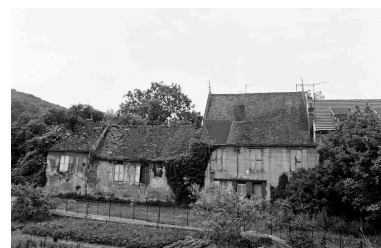
Vue générale, côté nord. Phot. Olivier Coquelle IVR22_19946001192X
