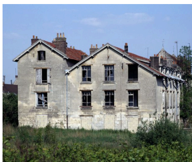
Vue générale, pignon ouest. Phot. Patrick Glotain IVR22_19936000512XA
