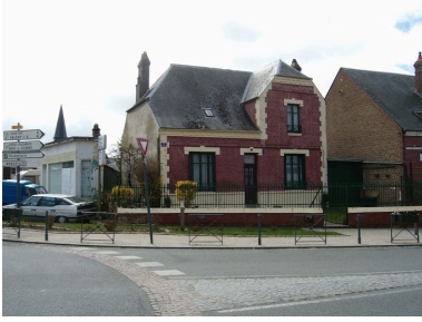
Vue générale. Phot. Inès Guérin IVR22_20058005379NUCA
