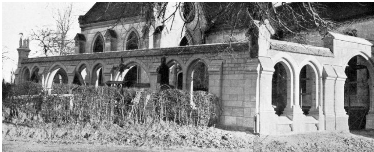
Enclos en cours d'achèvement, photographie par Lucien Hacquart, 1937-1938.
