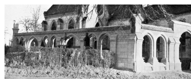
Enclos en cours d'achèvement, photographie par Lucien Hacquart, 1937-1938. Phot. Monnehay-Vulliet Marie-Laure IVR22_20118000281NUCA
