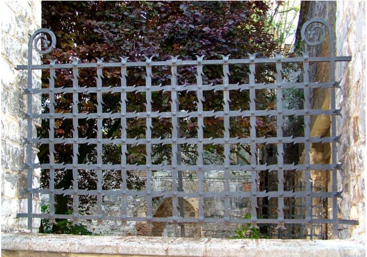
Fermeture d'une baie du square Pierre-Marie-Saguez à Amiens (ancienne église des Cordeliers), réalisée en 1936 par Serrurerie picarde sur le dessin de Gérard Ansart.
