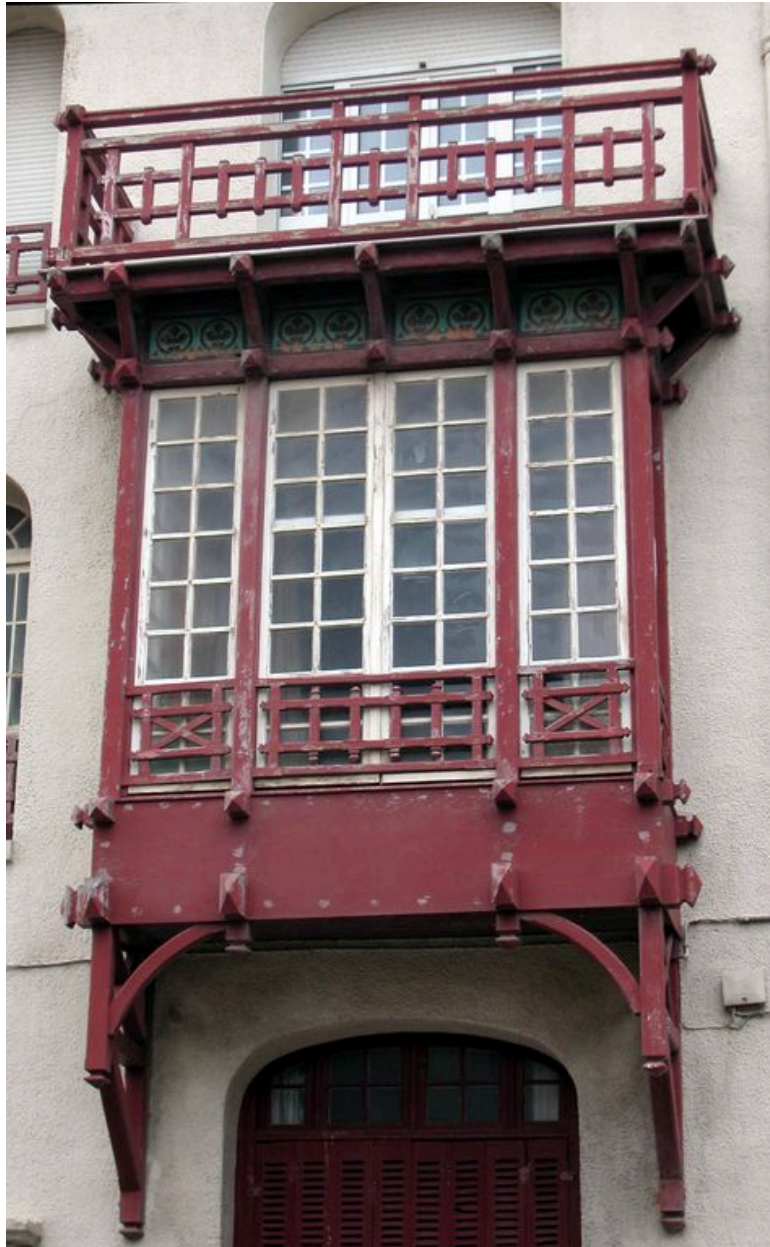
Détail du bow-window surmonté d'un balcon.
