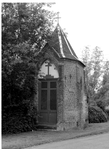
Vue générale de trois quarts. Phot. Philippe Dapvril IVR31_20045900466X
