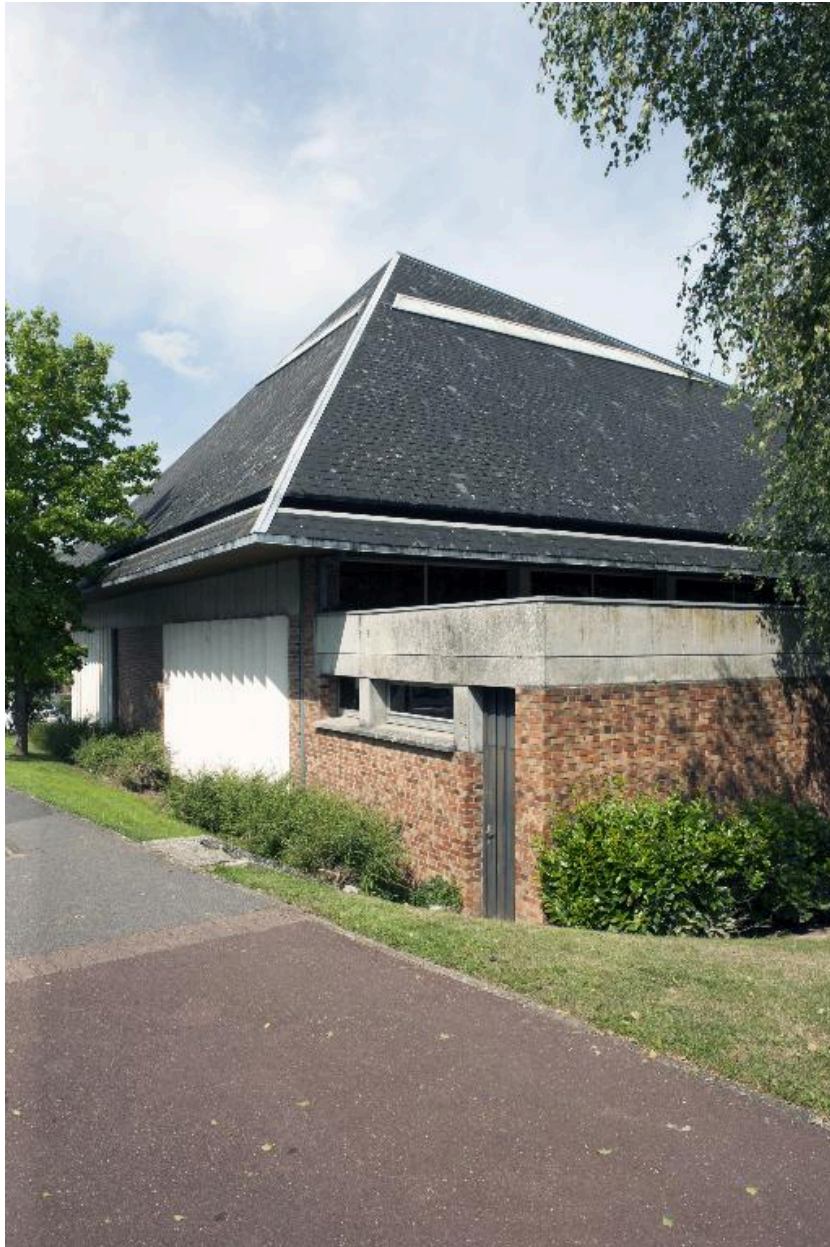
Vue extérieure du flanc droit de l'église.
