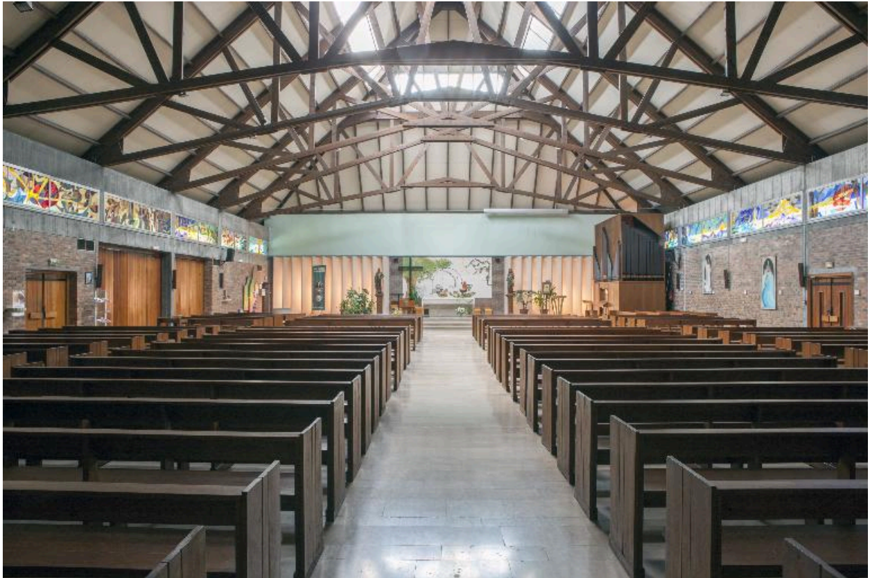
Vue générale vers le chœur.
