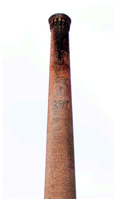
La cheminée portant la date de 1897.
