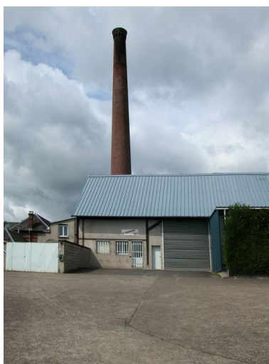
L'atelier de fabrication avec la cheminée en arrière-plan. Phot. Bertrand Fournier IVR22_20066090079NUCA
