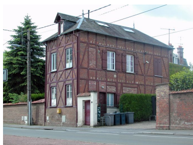
Vue latérale des bureaux. Phot. Bertrand Fournier IVR22_20066090078NUCA
