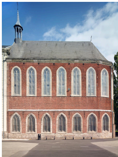
Façade de la chapelle depuis la cour des élèves. Phot. Pierre Thibaut IVR32_20225900260NUCA
