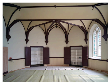
Salle du rez-de-chaussée de la chapelle, ancien réfectoire des élèves. Détail du voûtement de la partie est. Phot. Pierre Thibaut IVR32_20225900275NUCA
