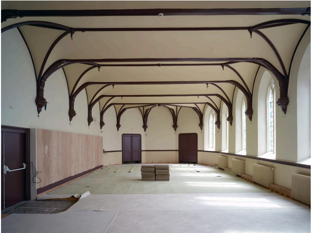
Salle du rez-de-chaussée de la chapelle, ancien réfectoire des élèves. Vue orientée ouest-est.
