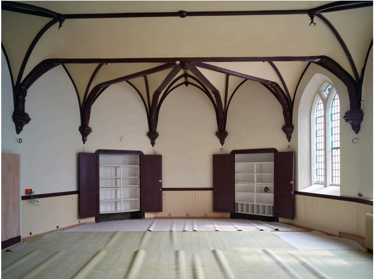
Salle du rez-de-chaussée de la chapelle, ancien réfectoire des élèves. Détail du voûtement de la partie est.
