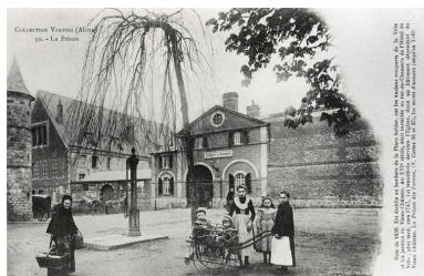
Vue de l'ancienne prison. Phot. Laurent Jumel IVR22_19970201116ZB
