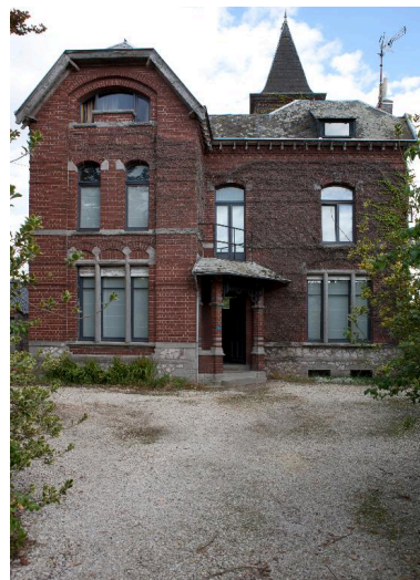
Maison 50 rue G.-Fournier. Phot. Pierre Thibaut IVR31_20125902201NUCA
