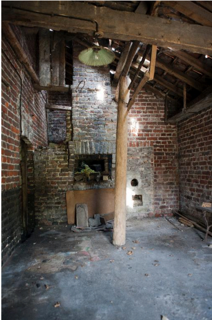
Maison élémentaire 3 rue du Trou-Marron ; vue de la remise et l'ancien four à pain.
