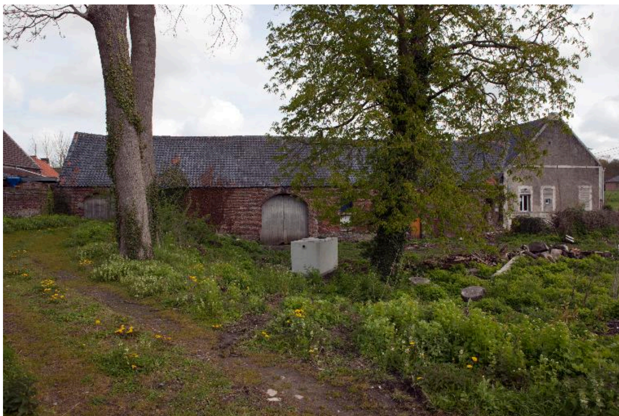
Ferme 13 rue de l'Eglise, vue générale depuis le cimetière.
