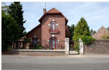
Maison 7 rue de l'Eglise. Phot. Pierre Thibaut IVR31_20125902174NUCA
