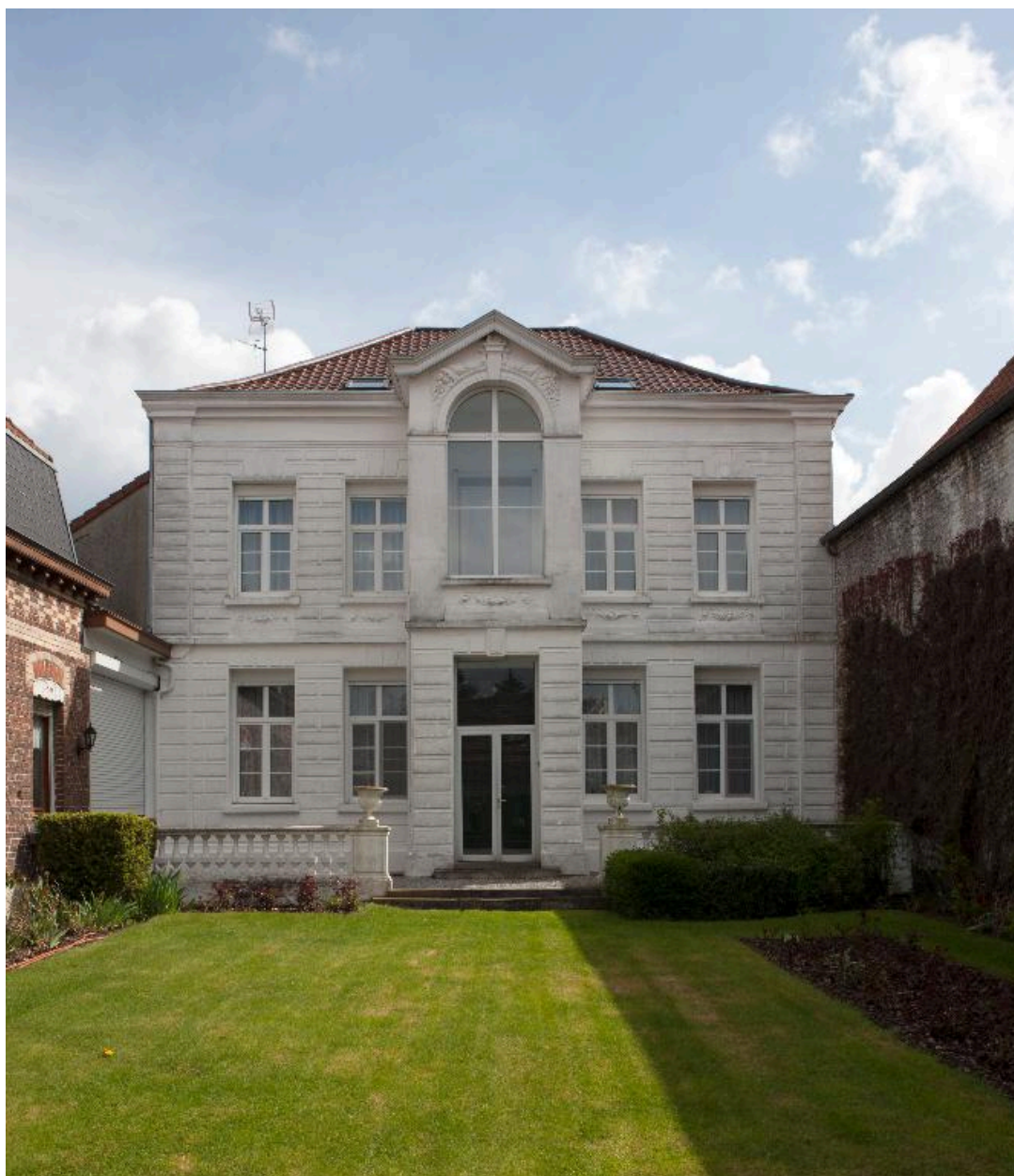
Ancienne maison patronale de la brasserie Namur 3 rue de l'Eglise.
