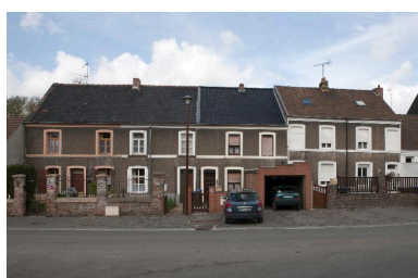
Vue générale de l'alignement de maisons 4 à 14 rue Marceau-Tison. Phot. Pierre Thibaut IVR31_20125901666NUCA
