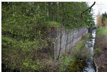
Le fort de Flines. Phot. Pierre Thibaut IVR31_20125901688NUCA
