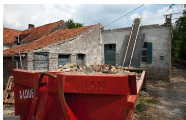
Vue générale de la maison élémentaire 3 rue du Trou- Marron en travaux (en 2012). Phot. Pierre Thibaut IVR31_20125901743NUCA
