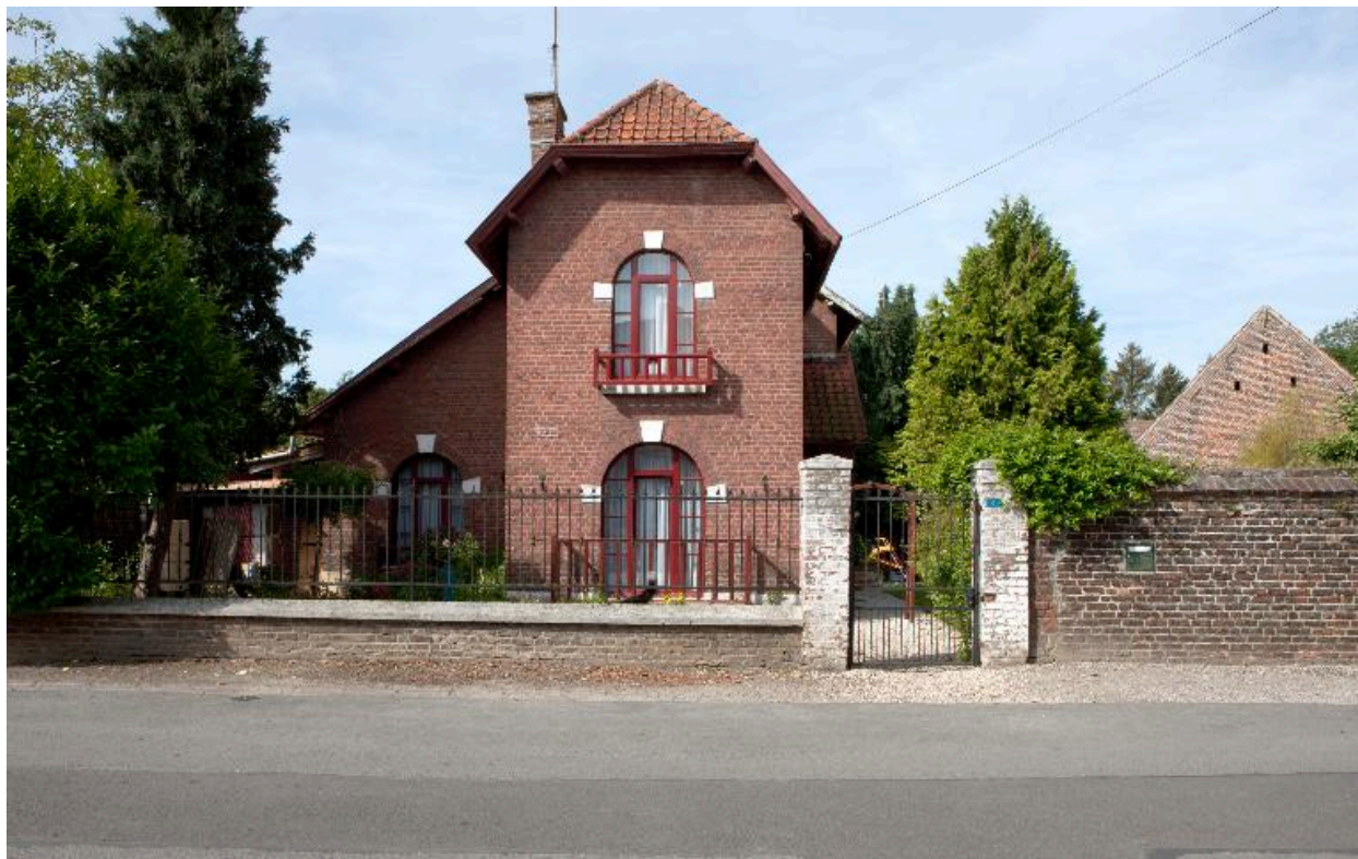
Maison 7 rue de l'Eglise.
