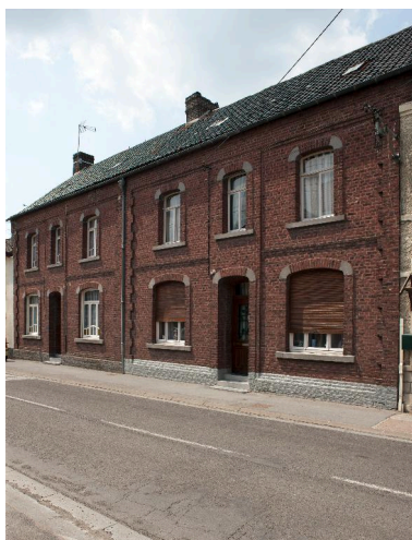
Vue générale de trois quarts de maisons jumelles 13-15 rue G. Fournier. Phot. Pierre Thibaut
