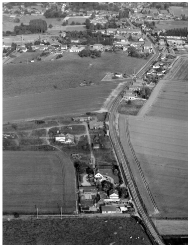
Vue aérienne de la scierie en 1994. Phot. Sanson Aviation IVR22_19946001519X
