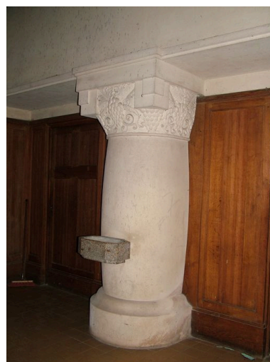
Vue du pilier soutenant la tribune. Phot. Inès Guérin IVR22_20050200573NUCA
