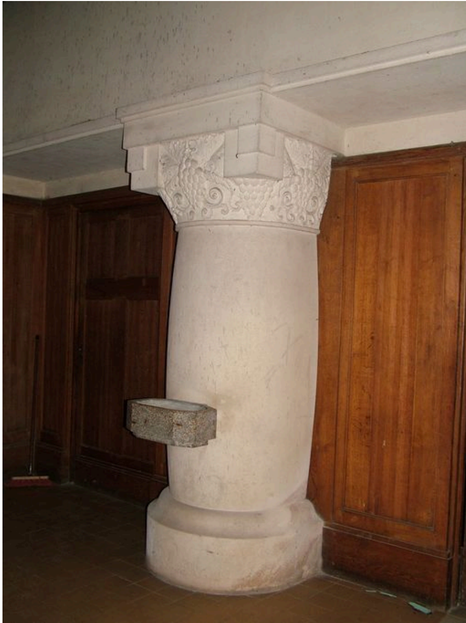
Vue du pilier soutenant la tribune.
