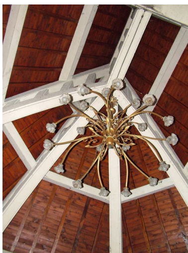
Lustre d'église situé dans le chœur. Phot. Inès Guérin IVR22_20050200606NUCA
