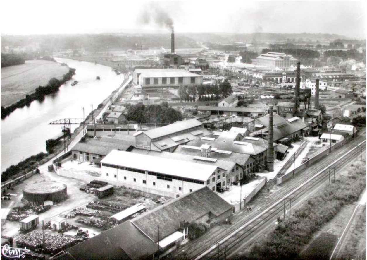
Vue générale de la plate-forme chimique dans les années 1940, au premier plan l'usine de minium de plomb de Rieux (AC Villers-Saint-Paul ; fonds local).
