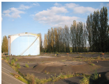
Cuve de méthanol construite en 1972 et emplacement des autres cuves. Phot. Clarisse Lorieux IVR22_20096005167NUCA
