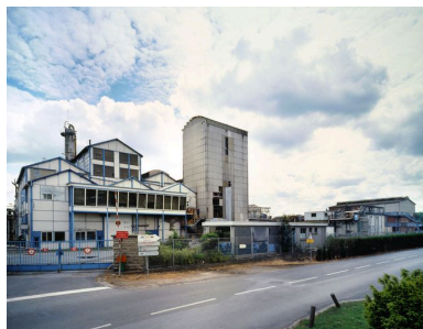
Unité d'urée formol démolie à la fin de l'année 2007. Phot. Thierry Lefébure IVR22_20076000027VA
