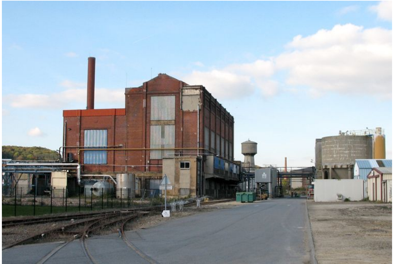
La centrale vapeur construite dans les années 1920 et le château d'eau.
