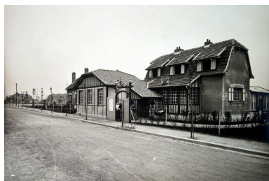
Longueau. Centre d'hygiène infantile, photographie, s. d. (C. A. M. T. ; 202 AQ 1189). Phot. Centre des Archives du Monde du Travail IVR22_20048010751NUCA
