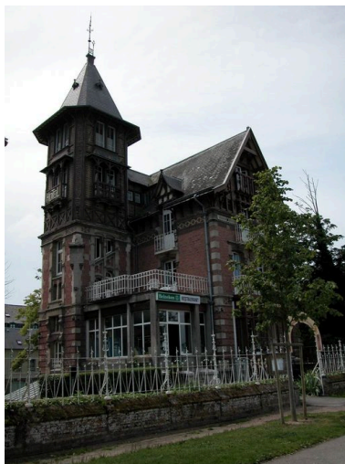
Elévation orientée vers la Baie de Somme.
