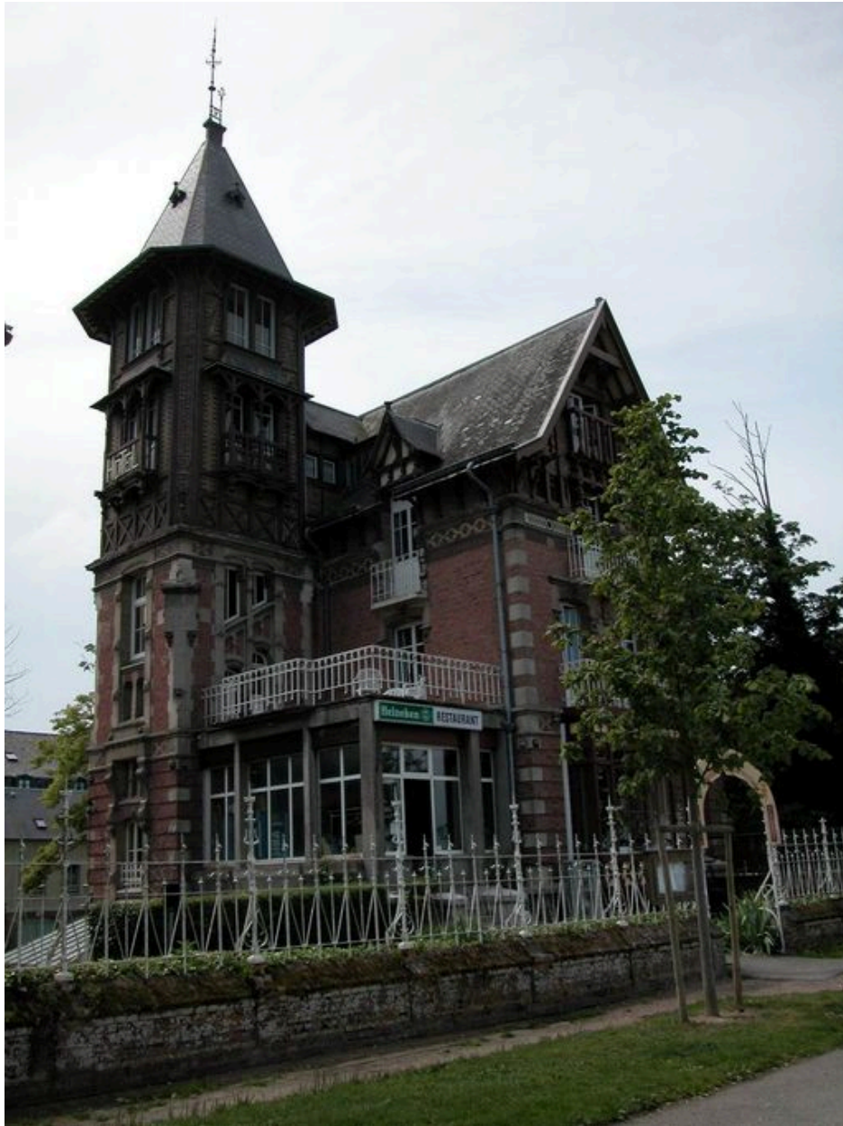
Elévation orientée vers la Baie de Somme.
