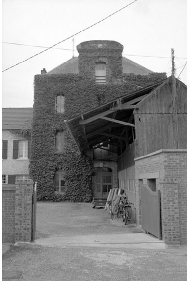
Bâtiment d'eau, élévation antérieure. Phot. Francis Dubuc IVR22_19908000607Z
