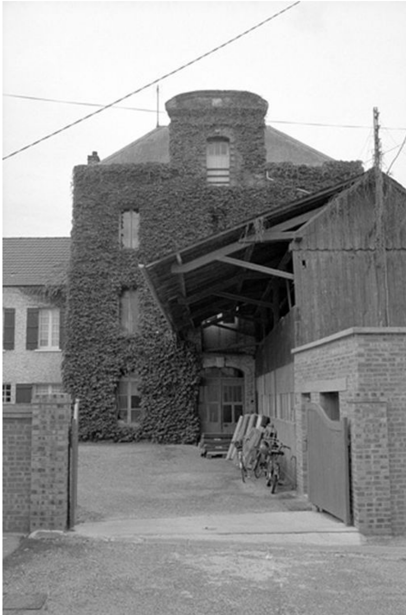
Bâtiment d'eau, élévation antérieure.
