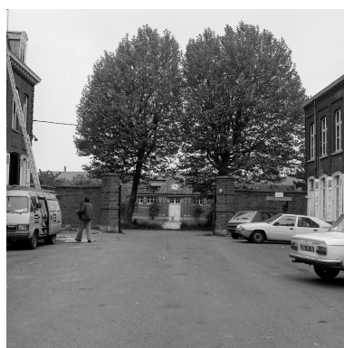
Entrée de l'usine, avenue Breuvart. Phot. Philippe Dapvril IVR31_19885900819X
