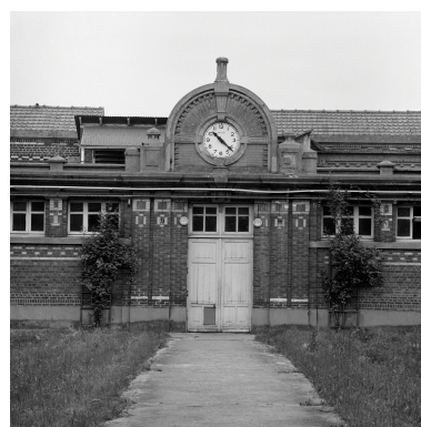
Elévation sud, détail. Phot. Philippe Dapvril IVR31_19885900820X
