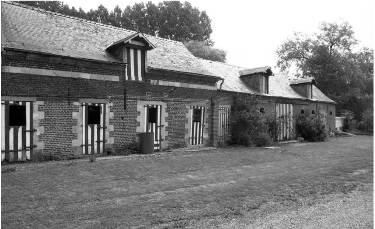
Vue de l'élévation sur cour des étables.
