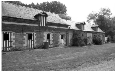
Vue de l'élévation sur cour des étables. Phot. Thierry Lefébure IVR22_19920201251Z
