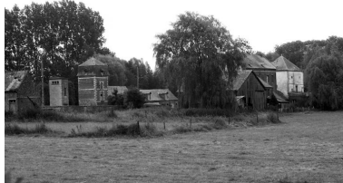
Vue d'ensemble des bâtiments, depuis l'ouest. Phot. Thierry Lefébure IVR22_19920201254Z
