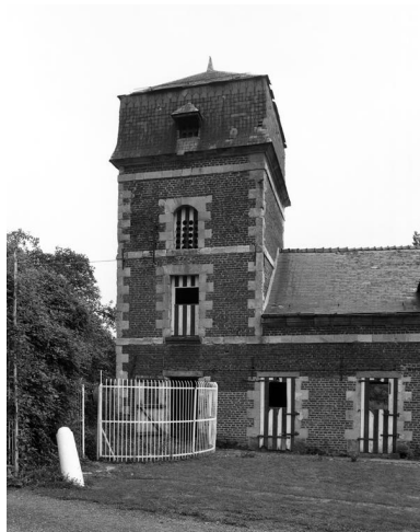
Vue d'ensemble du colombier, depuis le sud. Phot. Thierry Lefébure IVR22_19920201250Z
