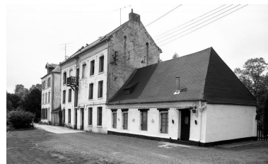
Vue d'ensemble de l'élévation sur cour de l'habitation, du bâtiment d'eau et de la boulangerie. Phot. Thierry Lefébure IVR22_19920201249Z
