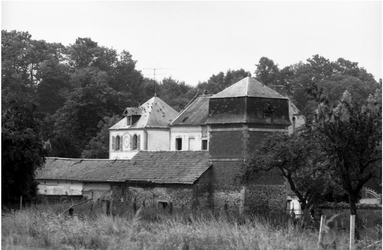
Vue d'ensemble des bâtiments, depuis le nord.
