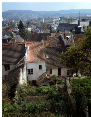
La face arrière d'une des maisons de la rue du château depuis le jardin en terrasse, avec la vue de la ville vers le sud. Phot. Thierry Lefébure IVR22_19940200337VA
