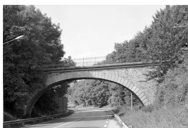
Pont au-dessus de l'ancienne ligne de chemin de fer vers La Ferté Milon (actuelle rocade). Phot. Thierry Lefébure IVR22_19950200389X
