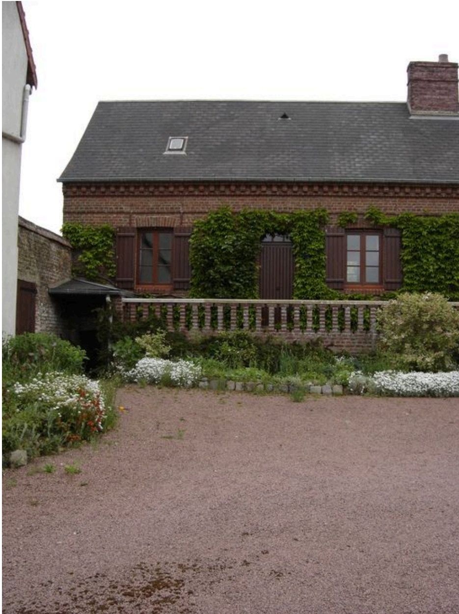
Vue de l'accès à la cave située sous le logis.
