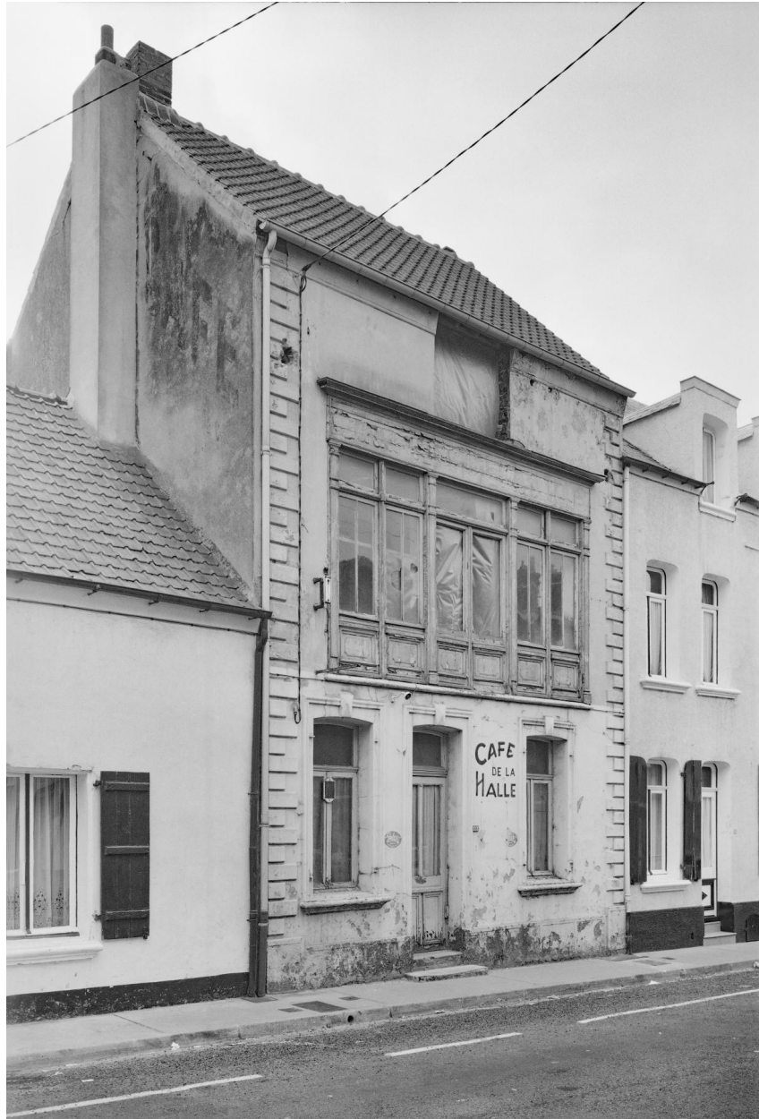
Vue générale du commerce depuis la rue.
