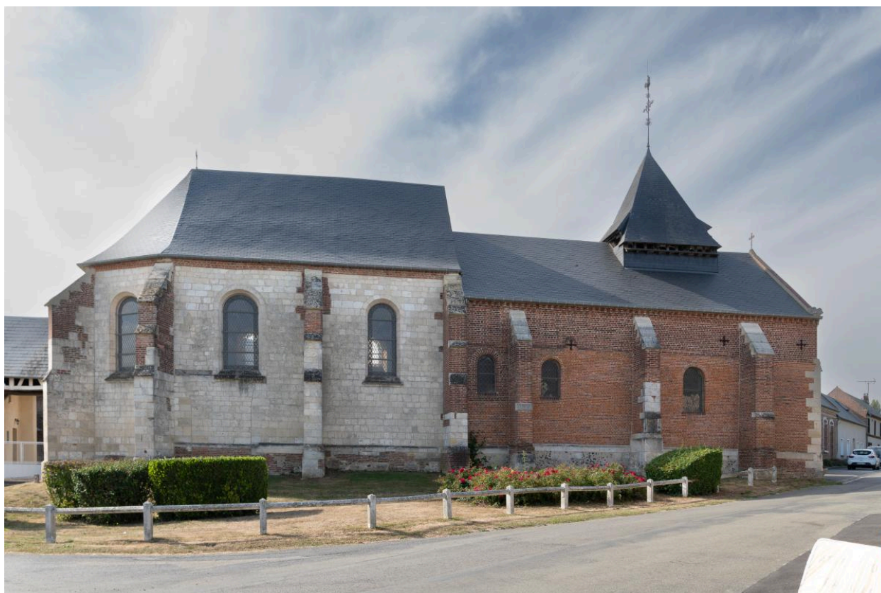
Élévation nord de l'église.
