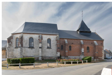
Élévation nord de l'église. Phot. Marc Kérignard IVR32_20226000854NUCA
