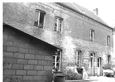
Vue de la façade sur cour de l'aile principale. Phot. Xavier-Philippe Guiochon IVR22_19980203127Z
