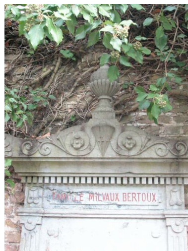
Vue du fronton. Phot. Laurent Nicolas IVR22_20048001336NUCA
