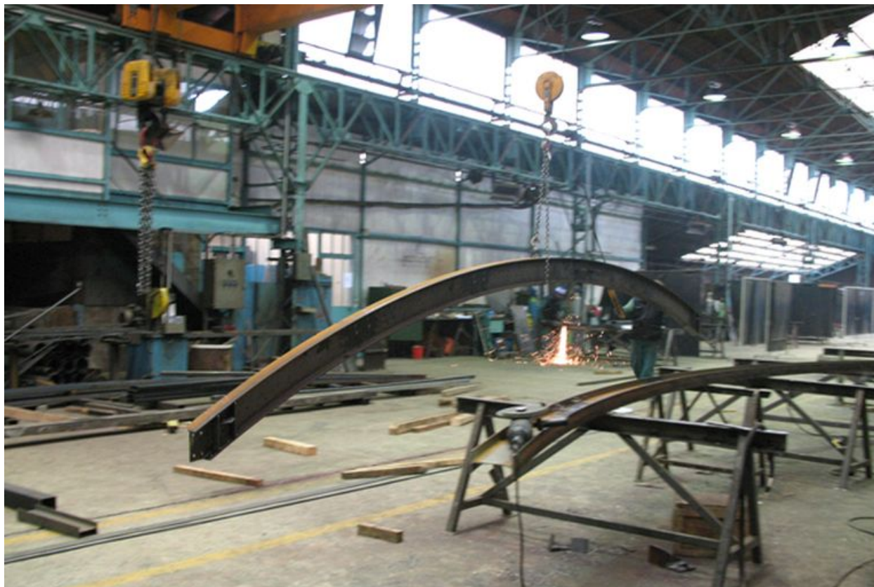
Poutrelle métallique dirigée vers l'atelier de peinture.
