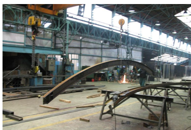
Poutrelle métallique dirigée vers l'atelier de peinture. Phot. Clarisse Lorieux IVR22_20076005239NUCA
