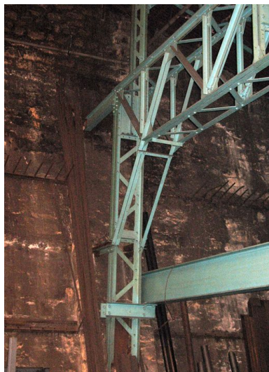
Détail de la charpente métallique contre le mur adossé au coteau. Phot. Clarisse Lorieux IVR22_20076005253NUCA
