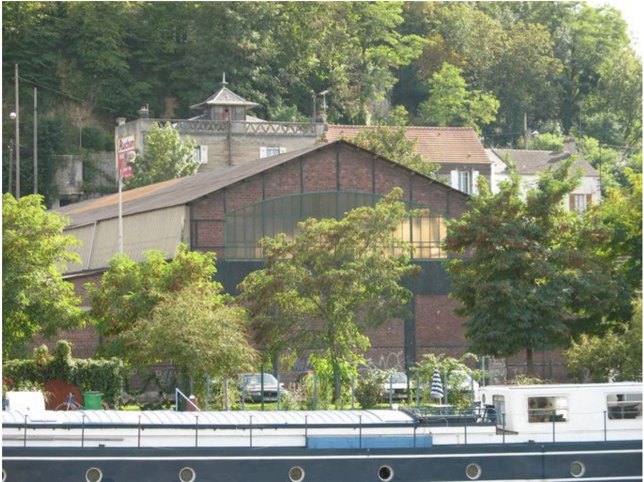
Vue de la halle principale de l'usine.
