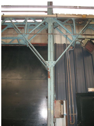
Détail de la poutrelle métallique et de la charpente. Phot. Clarisse Lorieux IVR22_20076005257NUCA
