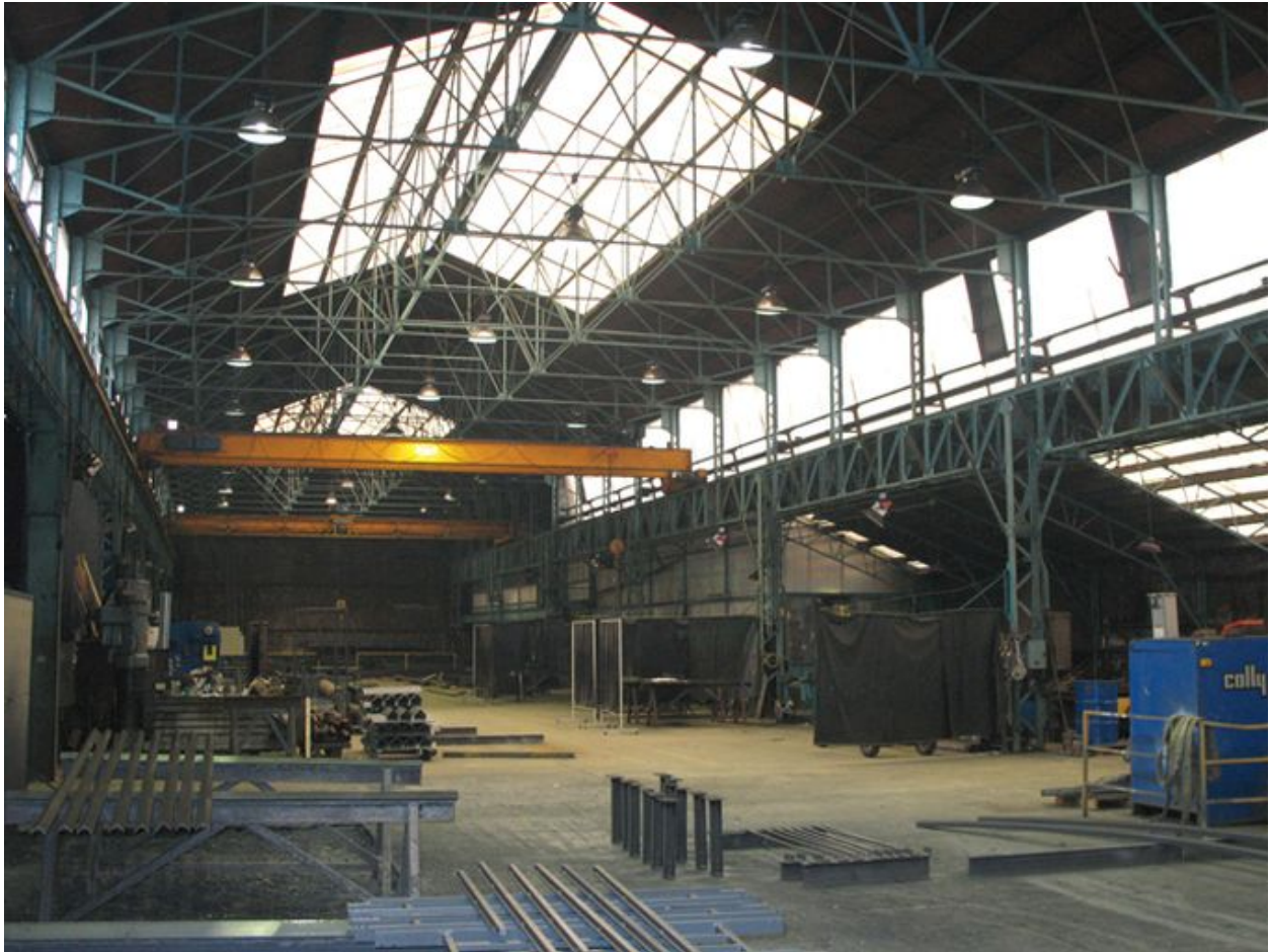
Atelier de finition vu vers le sud.
