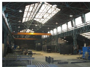
Atelier de finition vu vers le sud. Phot. Clarisse Lorieux IVR22_20076005142NUCA
