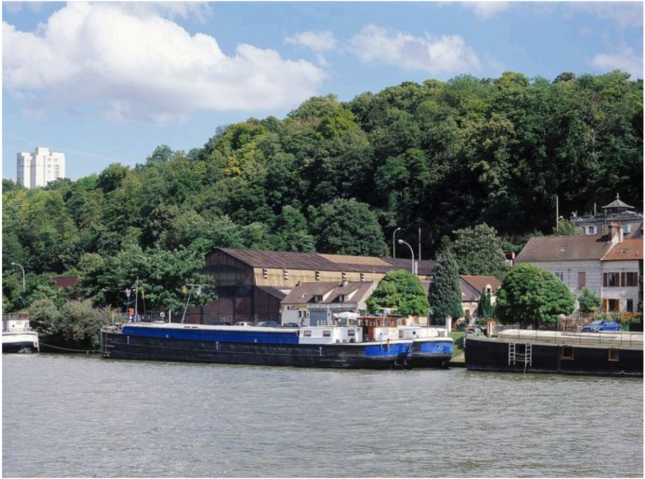
Usine Morel depuis la rive droite de l'Oise.
