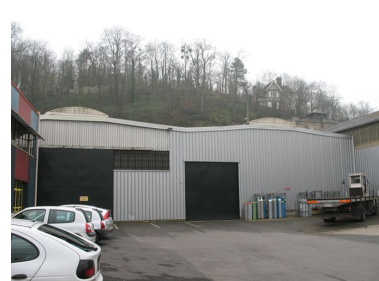
Cour de l'usine. Phot. Clarisse Lorieux IVR22_20076005237NUCA
