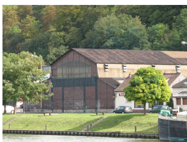
Vue générale de l'usine. Phot. Clarisse Lorieux IVR22_20066005010NUCA
