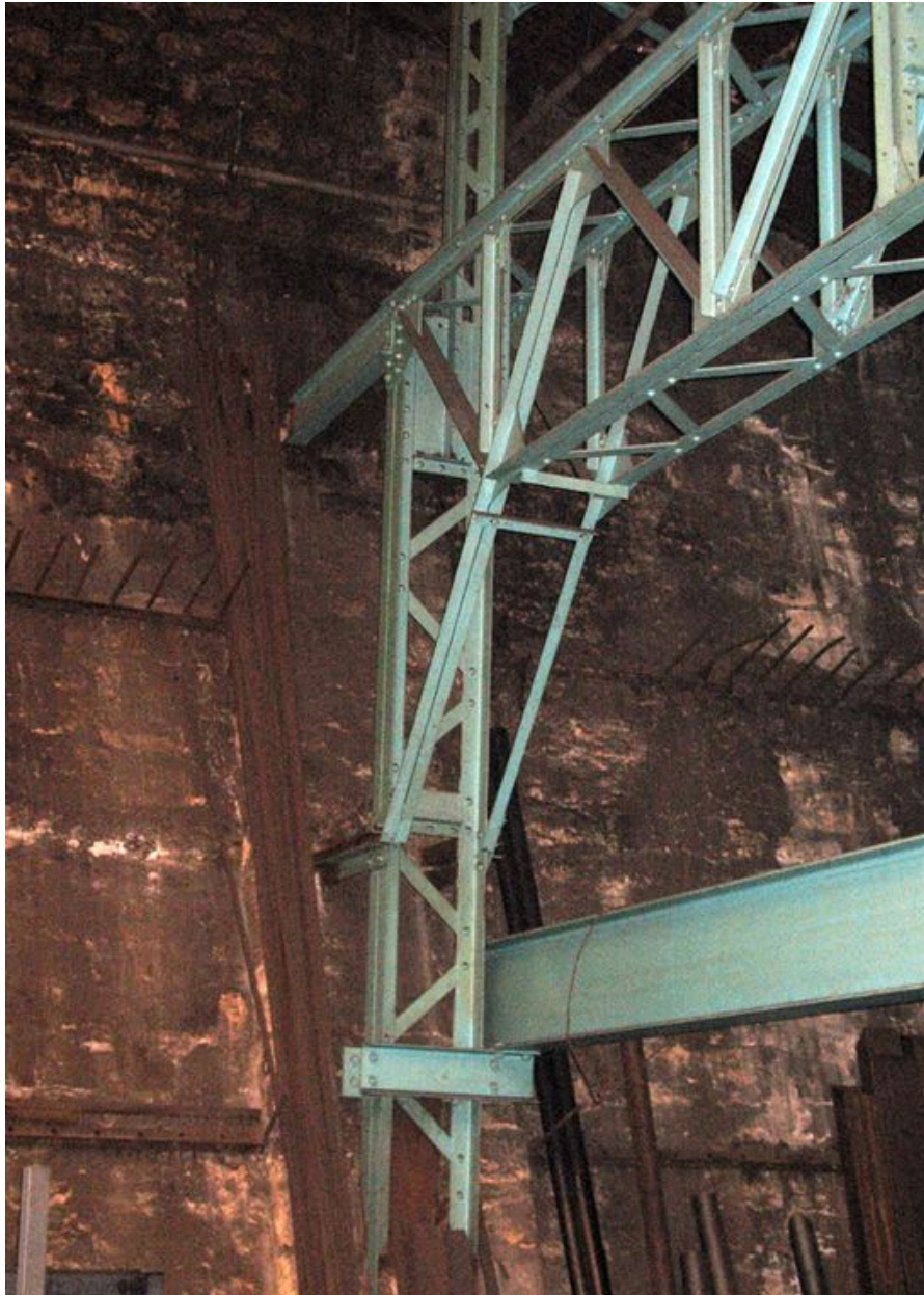
Détail de la charpente métallique contre le mur adossé au coteau.
