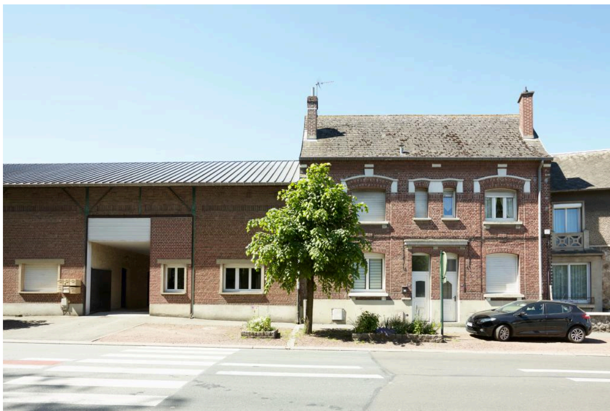
Vue de la façade depuis la rue du Faubourg de Péronne.
