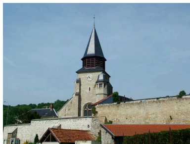
Vue du chevet. Phot. Inès Guérin IVR22_20030202724NUCA
