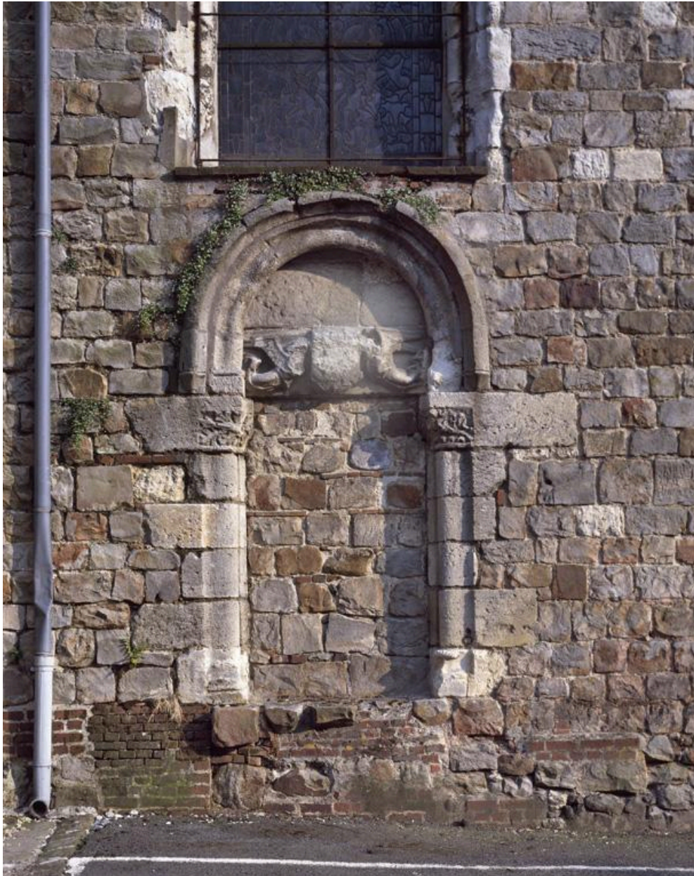
Vue de la porte romane, et du linteau, armorié du 14e ou du 15e siècle.
