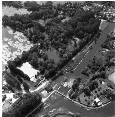
Vue aérienne, flanc nord-est.
