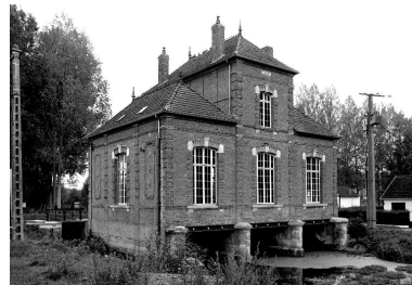
Vue d'ensemble, flanc ouest.
