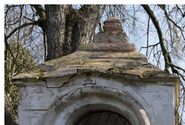
Détail de la partie supérieure de l'édicule portant la date : 1798. Phot. Marie-Laure Monnehay-Vulliet IVR22_20118000018NUCA
