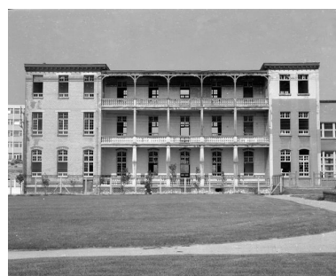
Façade donnant sur la rue où se déploient les galeries de cure, vue générale prise de face. Phot. Eric Dessert IVR31_19816203789X
