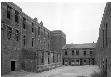
Cour, vue générale. Phot. Eric Dessert IVR31_19816203868X
