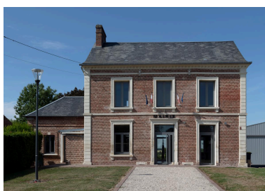
Mairie (ancien presbytère), vue depuis le nord-ouest.
