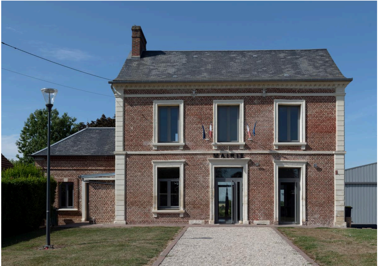
Mairie (ancien presbytère), vue depuis le nord-ouest.
