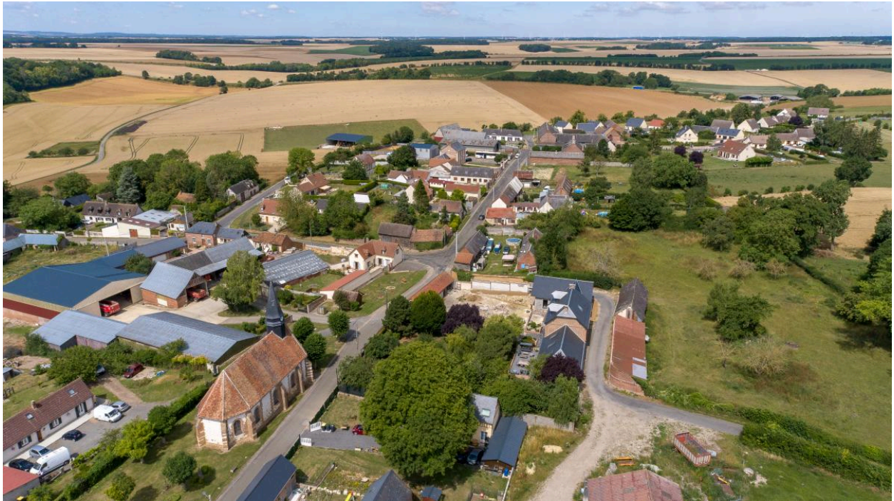
Vue aérienne du village depuis l'est.
