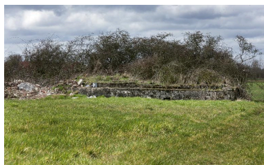
Elévation antérieure, vers l'ouest Phot. Jean-Marc Ramette IVR31_20145904421NUCA
