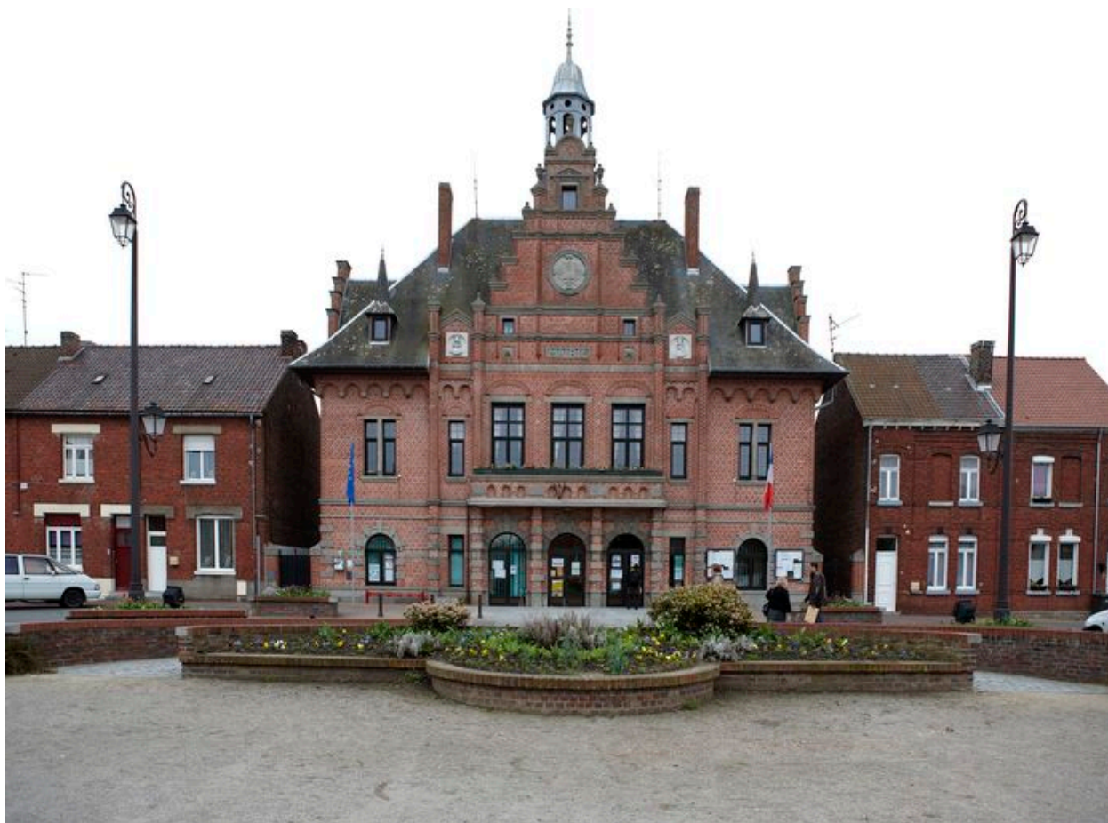
Vue générale de l'élévation antérieure.
