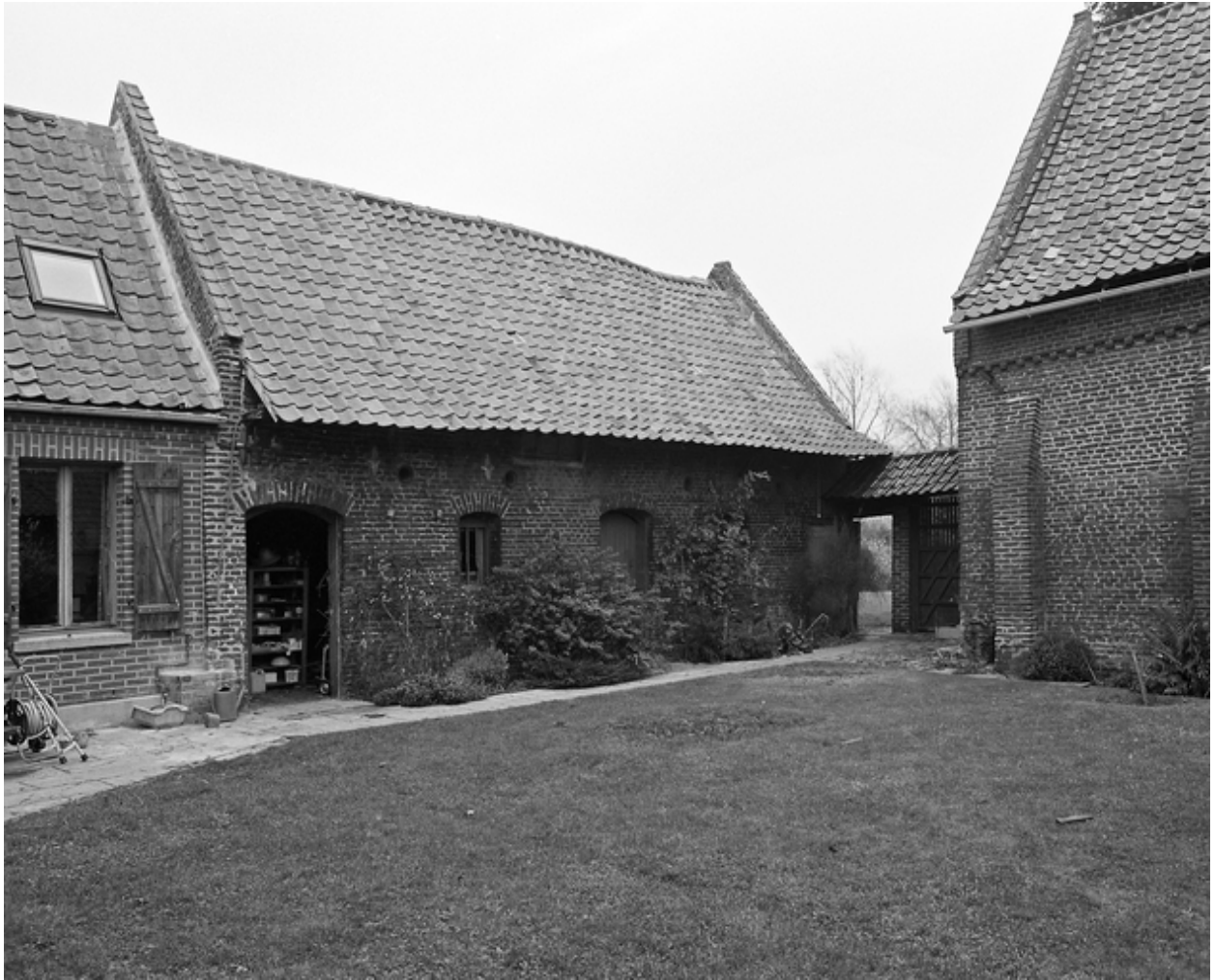
Élévation antérieure de l'étable-écurie sur cour.
