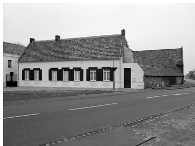
Vue générale de trois quarts de la ferme. Phot. Philippe Dapvril IVR31_20045901110X
