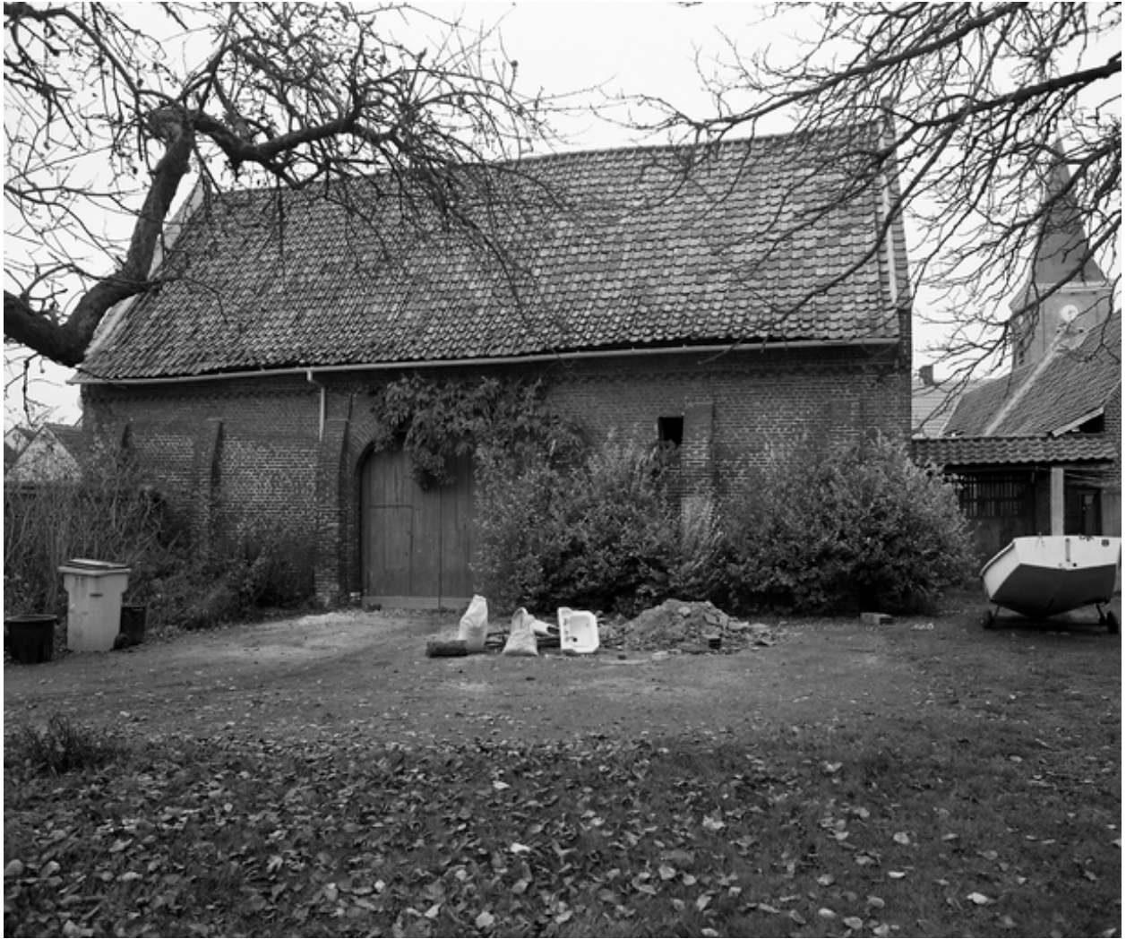
Elévation postérieure de la grange.
