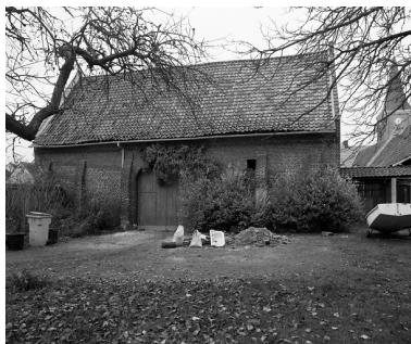
Elévation postérieure de la grange. Phot. Philippe Dapvril IVR31_20045901111X
