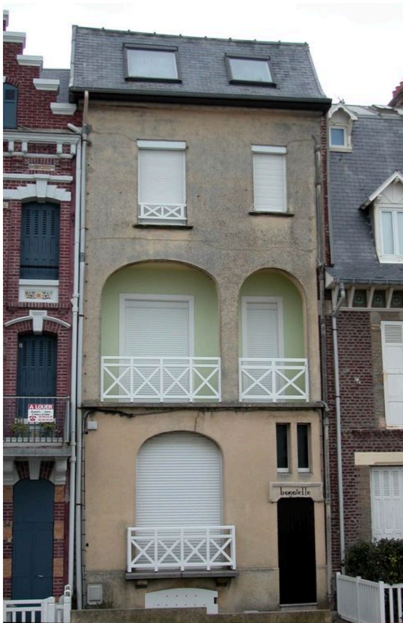
Vue d'ensemble depuis l'esplanade.
