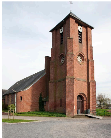
Vue générale de la façade occidentale.
