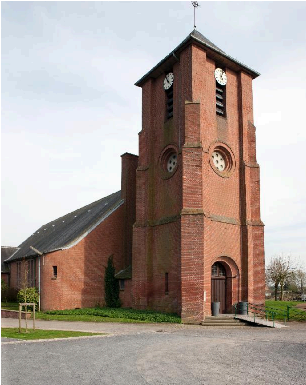
Vue générale de la façade occidentale.
