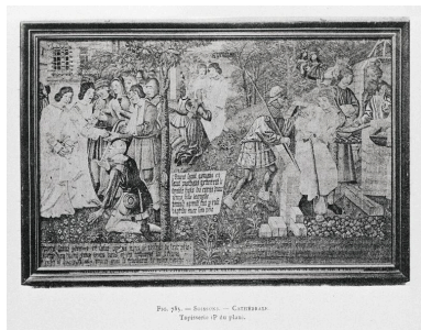
Vue de la pièce murale et de son cadre, avant 1914 (photographie d'Étienne Moreau-Nélaton, publiée dans "Les églises de chez nous", figure 785). Phot. Thierry Lefébure IVR22_19950202585ZB
