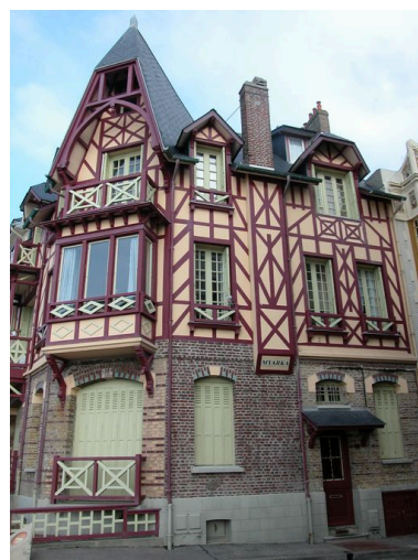
Façade sur la rue Faidherbe. Phot. Elisabeth Justome IVR22_20058003178NUCA
