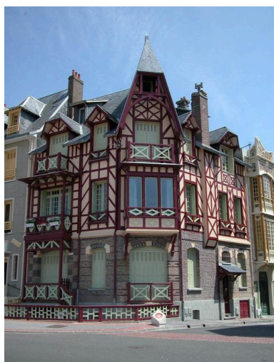
Vue d'ensemble depuis l'esplanade. Phot. Elisabeth Justome IVR22_20038005257NUCA
