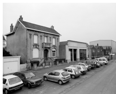
Vue générale de l'usine et de la maison patronale. Phot. Philippe Dapvril IVR31_20055900498X
