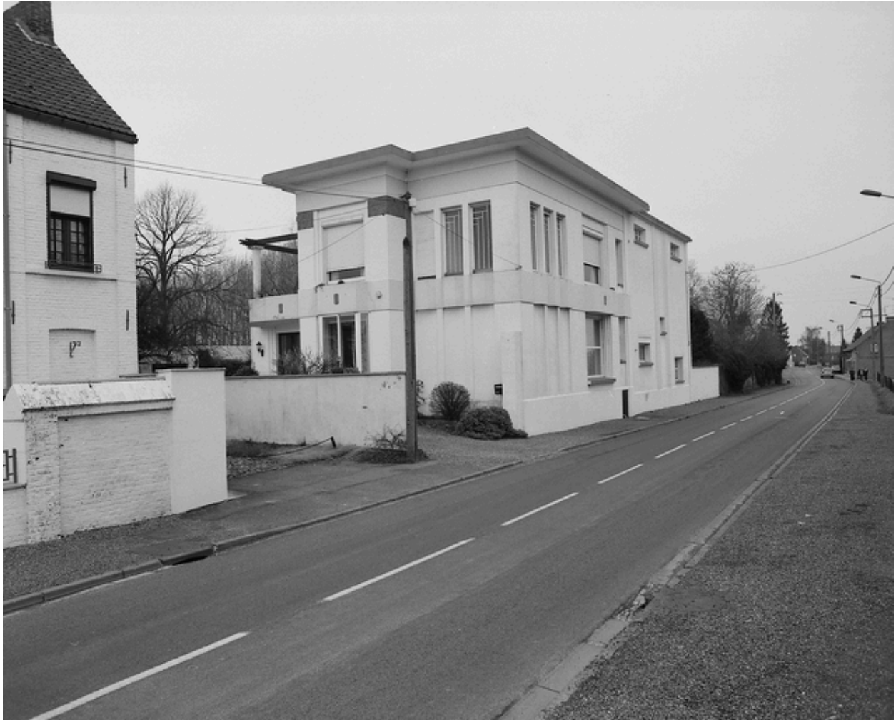
La façade sobre sur rue de la maison Art-Déco.
