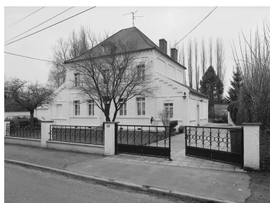
Maison, 681 rue Lasson. Phot. Philippe Dapvril IVR31_20045900046X
