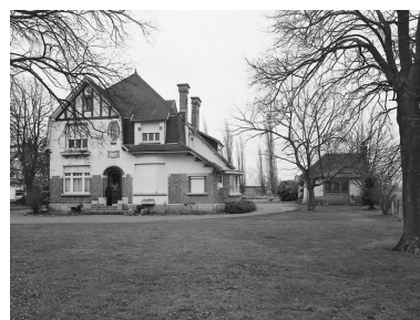
Maison, rue du Corbeau, construite en 1932. Phot. Philippe Dapvril IVR31_20045900041X
