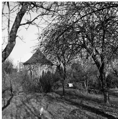
Vue du pavillon. Phot. Thierry Lefébure IVR22_20020201126X
