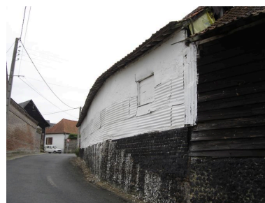
Autre vue des bâtiments longeant la rue. Phot. Inès Guérin IVR22_20058005984NUCA
