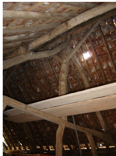
Autre vue d'une ferme de charpente. Phot. Inès Guérin IVR22_20058005854NUCA
