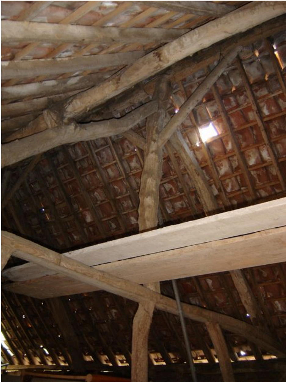
Autre vue d'une ferme de charpente.
