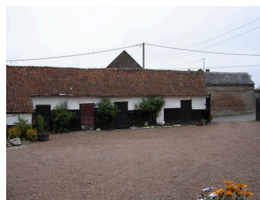
Vue des étables les plus au nord. Phot. Inès Guérin IVR22_20058005848NUCA
