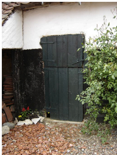
Vue détaillée d'une autre porte. Phot. Inès Guérin IVR22_20058005850NUCA
