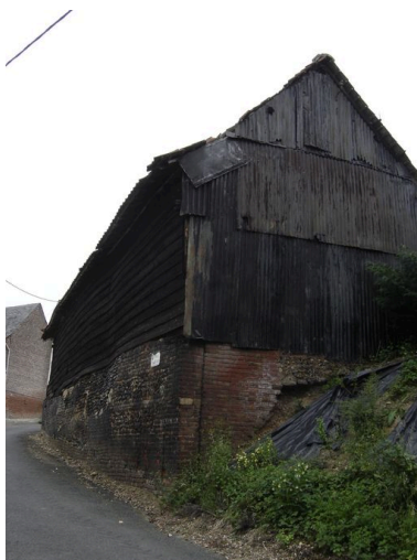
Vue des bâtiments situés le long de la rue François Curé. Phot. Inès Guérin IVR22_20058005982NUCA
