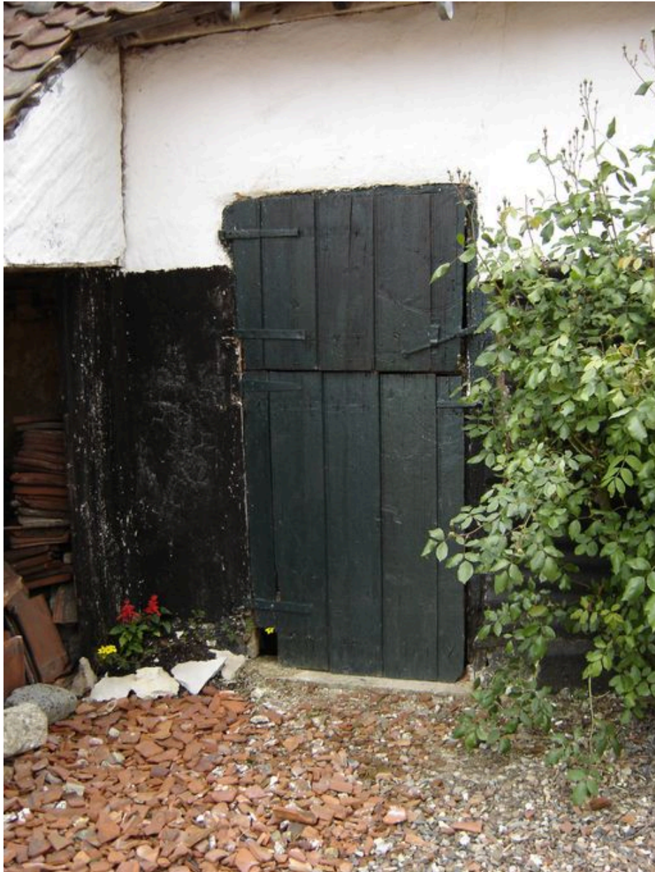
Vue détaillée d'une autre porte.
