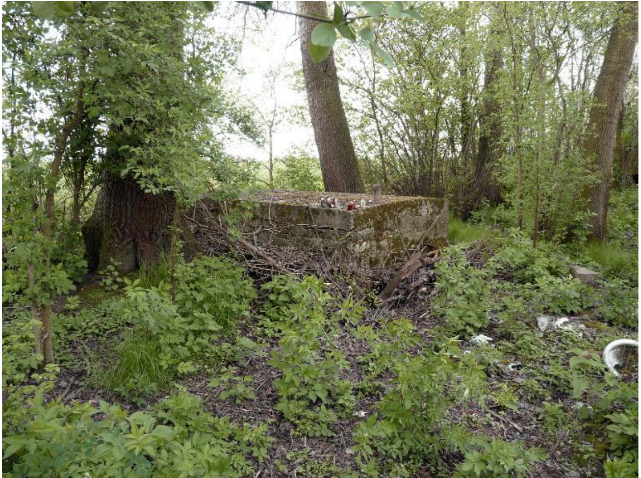
Casemate à munitions ? (611) vers le sud
