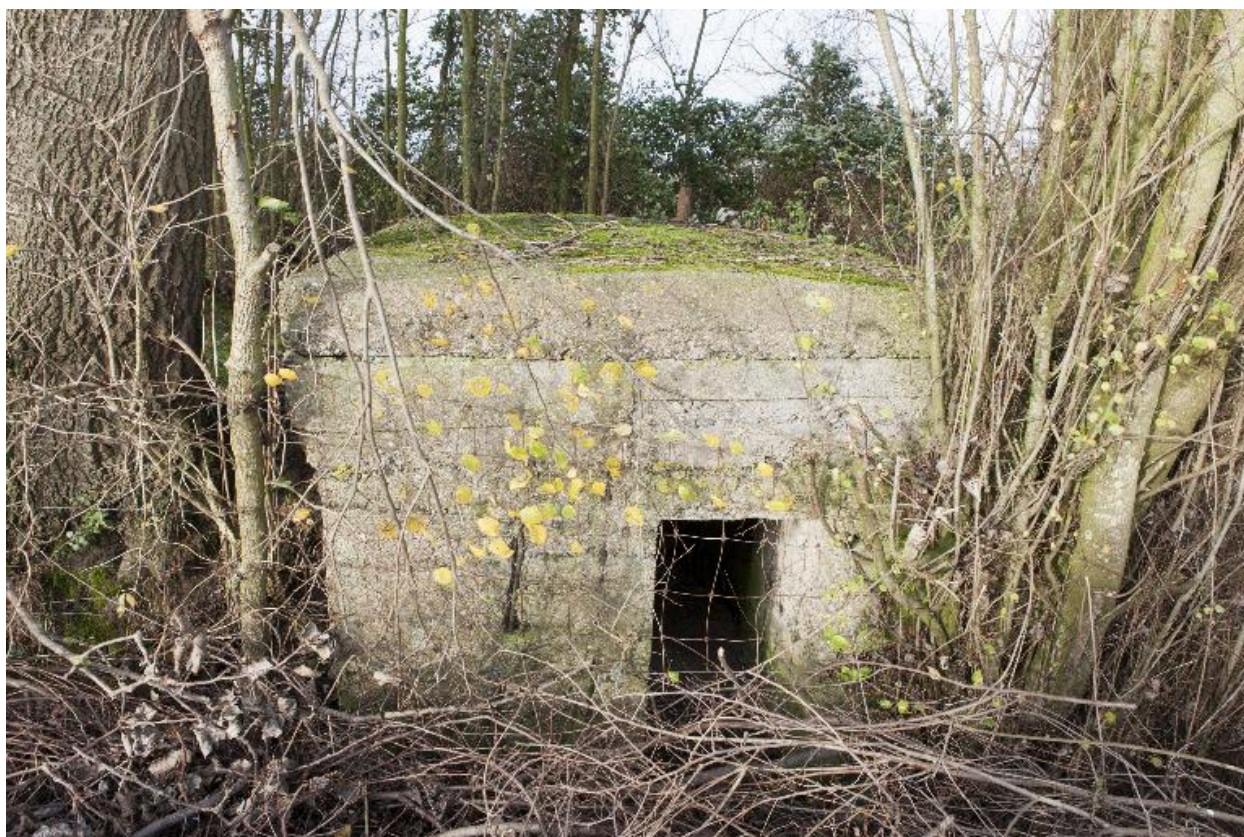
Casemate à munitions ? (611) : entrée sur l'émévation sud-est
