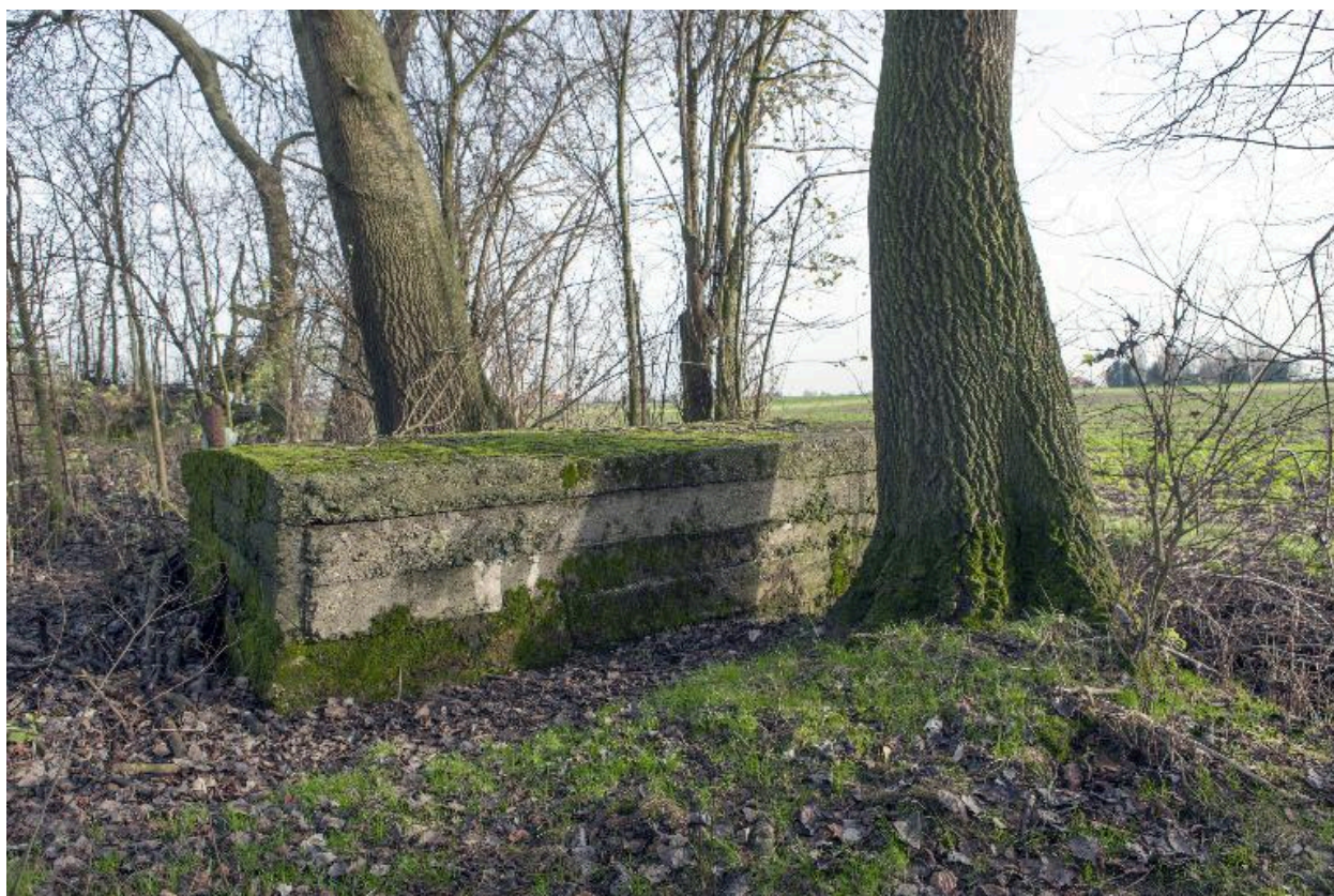
casemate à munitions ? (611) vers l'est
