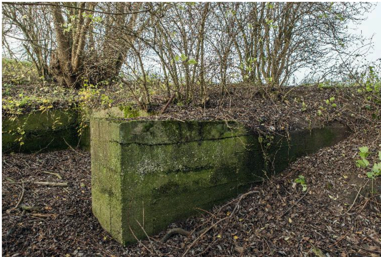
Cuve ouverte entre (88) et (89). Vers l'ouest
