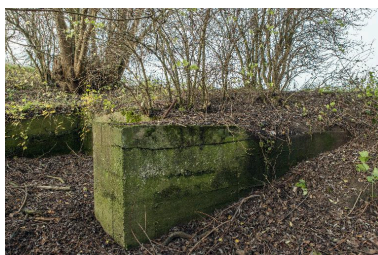
Cuve ouverte entre (88) et (89). Vers l'ouest Phot. Jean-Marc Ramette IVR32_20175901037NUCA
