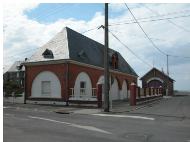
Vue d'ensemble et de trois-quarts. Phot. Elisabeth Justome IVR22_20058003051NUCA
