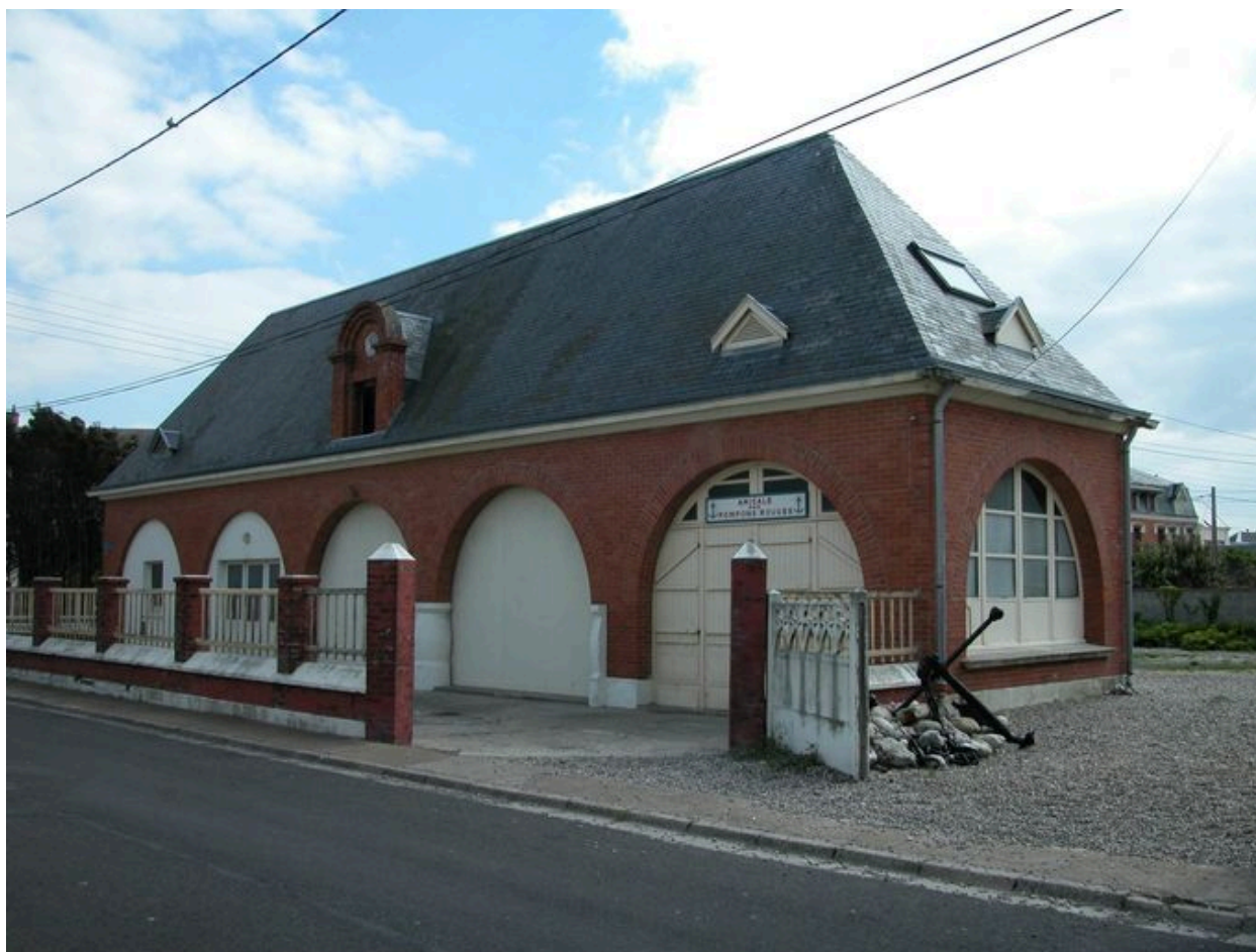
Vue de trois-quarts depuis le nord.
