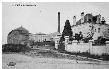
Vue générale sud-est de l'usine, vers 1930 (coll. part.). Phot. Thierry Lefébure IVR22_19950202992XB
