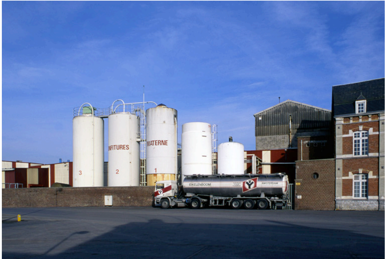
Vue des silos à sucre, édifiés au sud de l'usine.
