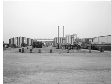
Côté ouest de l'usine occupé par des magasin industriels récents et par la station d'épuration. Phot. Thierry Lefébure IVR22_19950202995V
