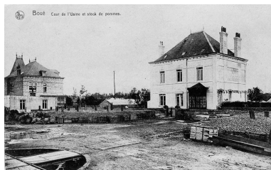
Les deux logements patronaux vus depuis la cour de l'usine, [s.d.] (coll. part.). Phot. Thierry Lefébure IVR22_19950202984XB
