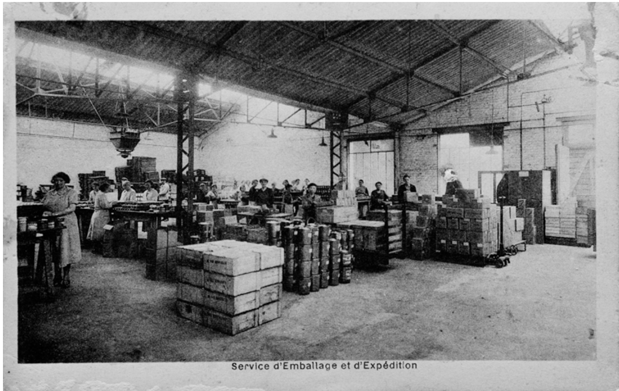
Vue intérieure du bâtiment réservé à l'emballage et à l'expédition, vers 1930 (coll. part.).
