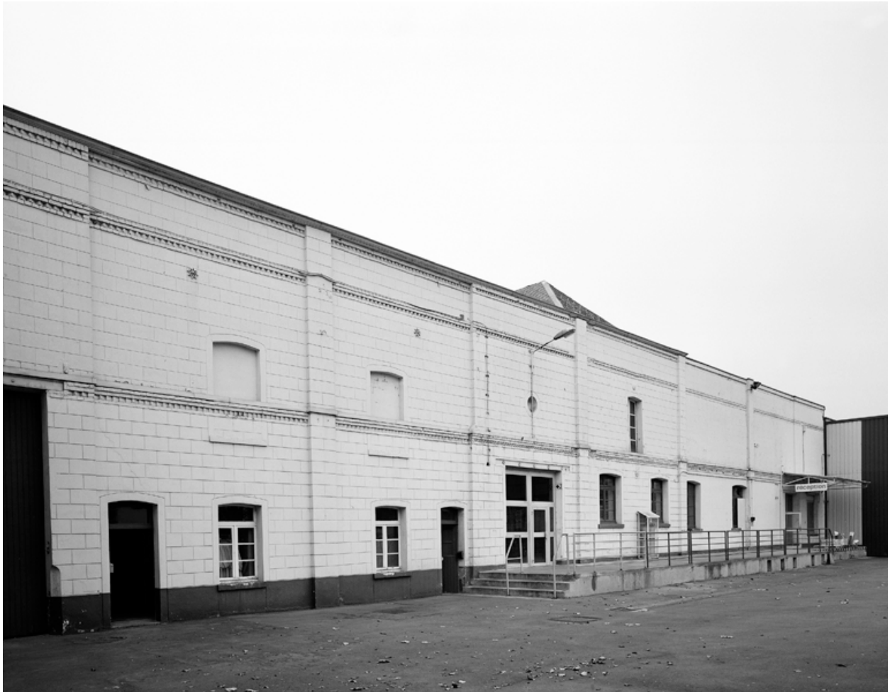
Elévation sur cour d'un ancien bâtiment de l'usine, occupé aujourd'hui par le laboratoire, des vestiaires et la réception des emballages.
