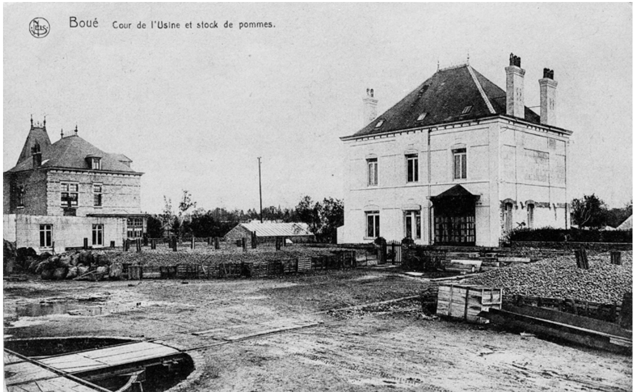
Les deux logements patronaux vus depuis la cour de l'usine, [s.d.] (coll. part.).
