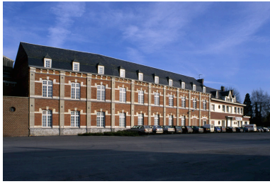
Façade de l'atelier de fabrication reconstruit vers 1922. Phot. Christiane Riboulleau IVR22_19960200038ZA
