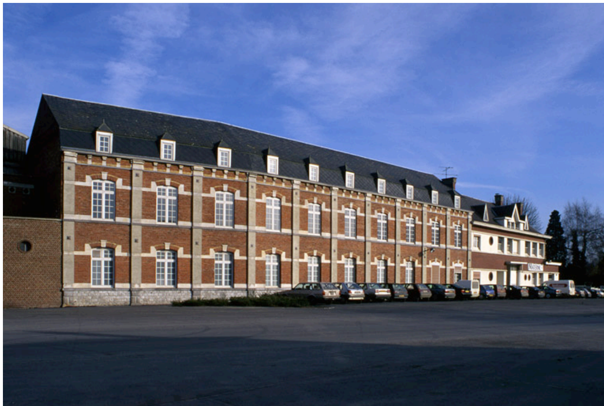
Façade de l'atelier de fabrication reconstruit vers 1922.
