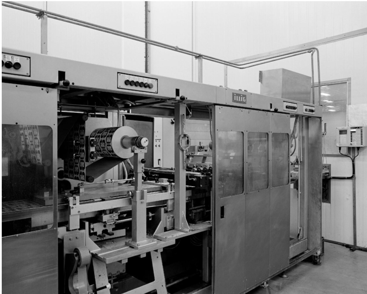
Partie de la ligne de thermoformage où les tetrapacks de compote de pommes reçoivent un opercule.
