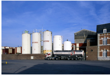
Vue des silos à sucre, édifés au sud de l'usine. Phot. Christiane Riboulleau IVR22_19960200040ZA
