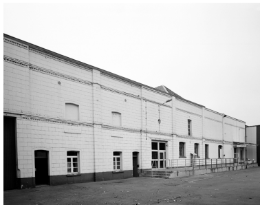
Elévation sur cour d'un ancien bâtiment de l'usine, occupé aujourd'hui par le laboratoire, des vestiaires et la réception des emballages. Phot. Thierry Lefébure IVR22_19950202994V
