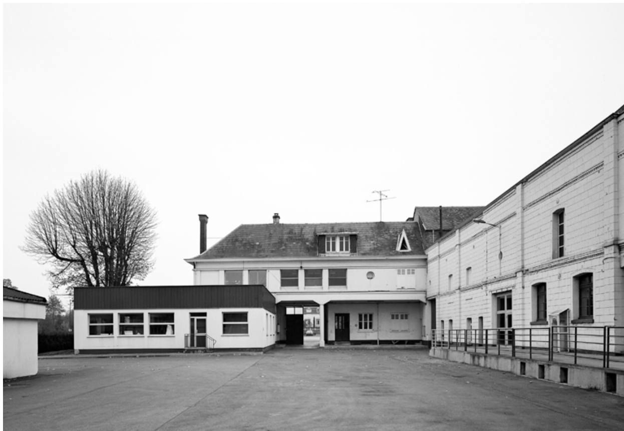
Elévation sur cour des bureaux.
