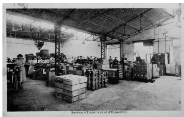
Vue intérieure du bâtiment réservé à l'emballage et à l'expédition, vers 1930 (coll. part.). Phot. Thierry Lefébure IVR22_19950202997XB
