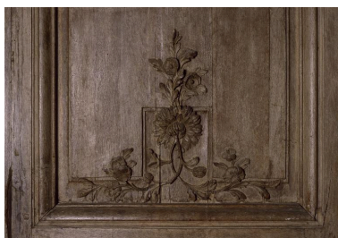
Détail du décor des lambris du mur nord. Phot. Irwin Leullier IVR22_20010202330ZA
