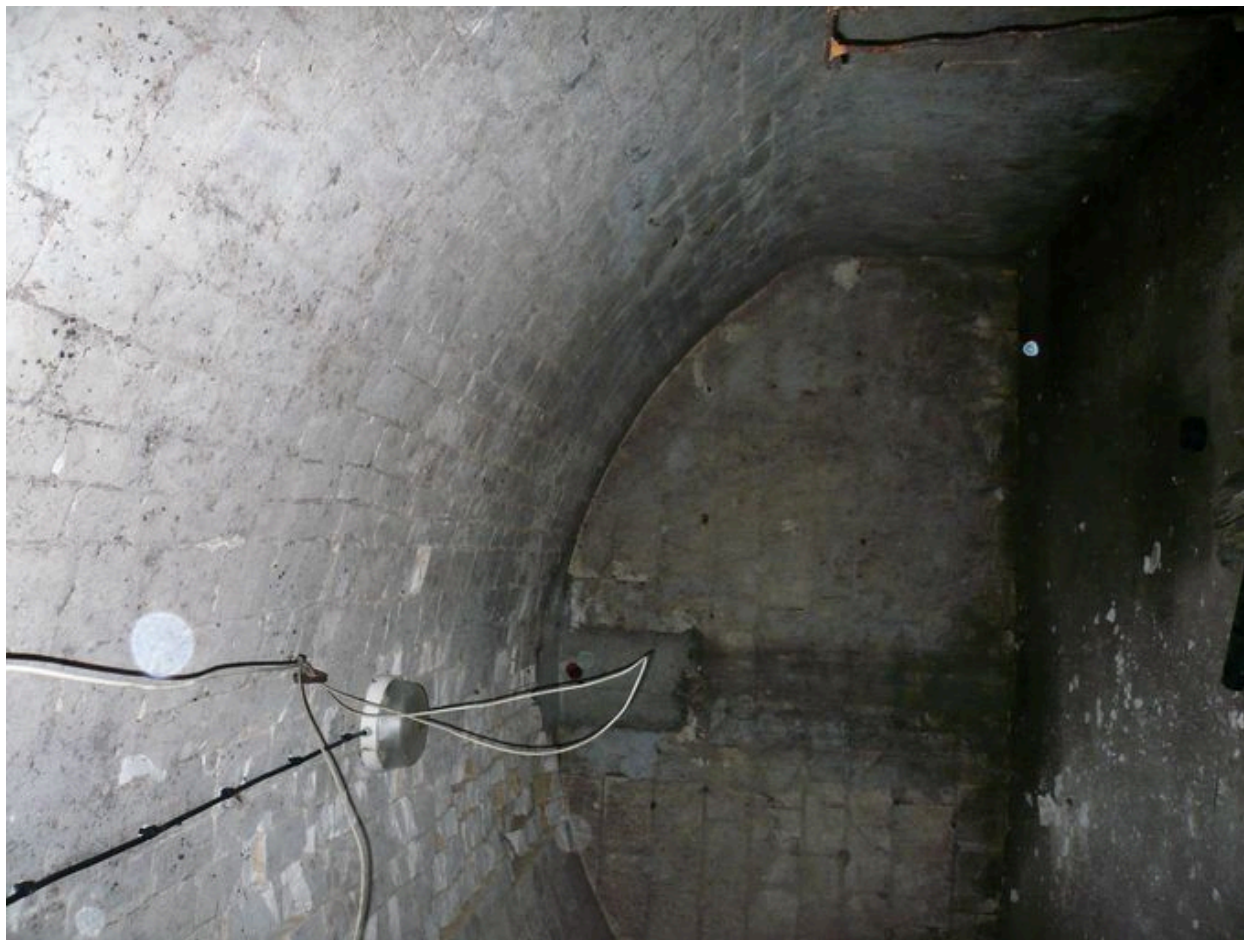
Vue de la seconde cave voûtée en pierre de taille.
