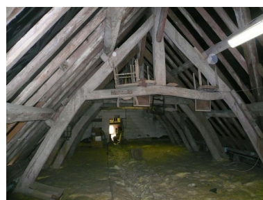
Vue de la charpente du logis. Phot. Inès Guérin IVR22_20078005869NUCA
