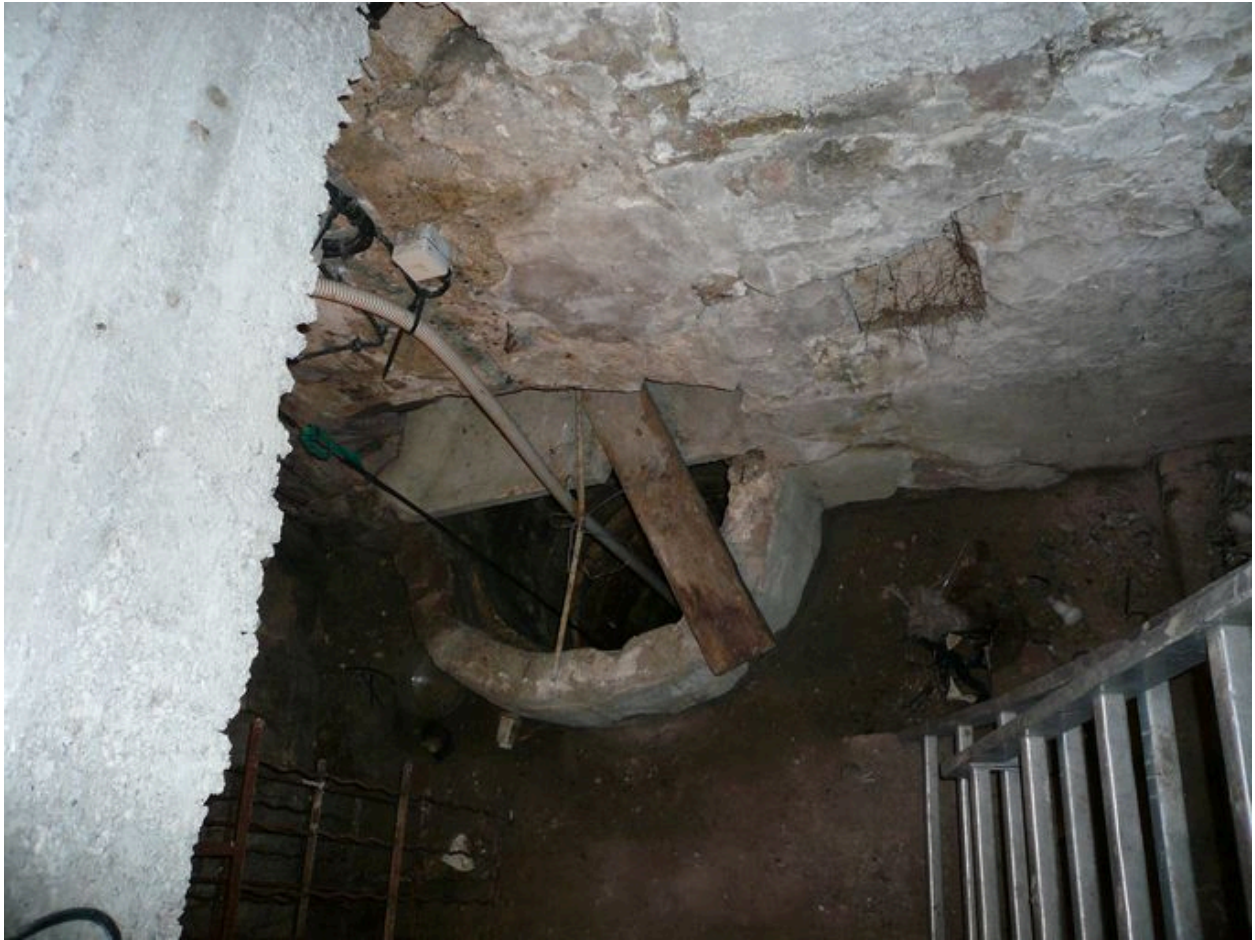
Vue du puits à l'intérieur de la cave.
