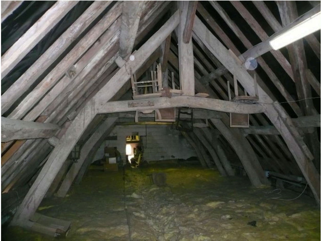
Vue de la charpente du logis.
