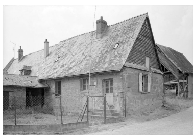
Elévation antérieure. Phot. Jean-Michel Perrin IVR22_19846000986X
