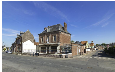
Vue d'ensemble. Phot. Thierry Lefébure IVR22_20158000424NUC2A
